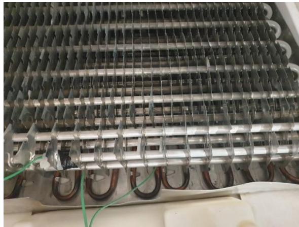
Şekil 4.5. Buz zme amacıyla kullanılan ısı deđiřtiricinin yerleřimi.
