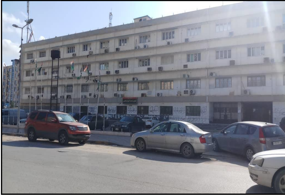
Fotoğraf 16. Bünyesinde Birçok Daire ve Kurumu Barındıran İdari Bir Bina, Hums
