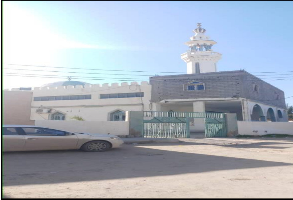
Fotoğraf 36. Eski Zayed El-Ğarip Camii, Hums
