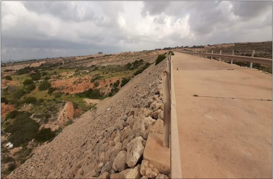
Fotoęraf 13. Hums Őehri Batısındaki Et-Tevalib Vadisi Barajı
