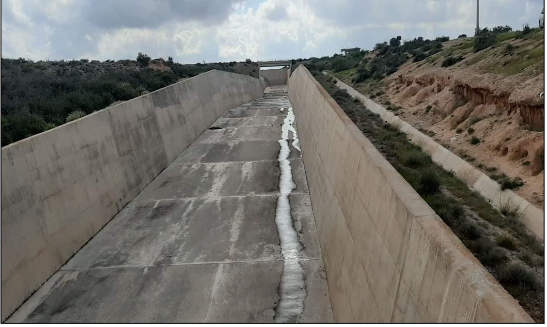
Fotoğraf 8. Hums Şehrinin Güneyinde Onarımı Yapılmış Lebda Vadisi Barajı Kanalı
