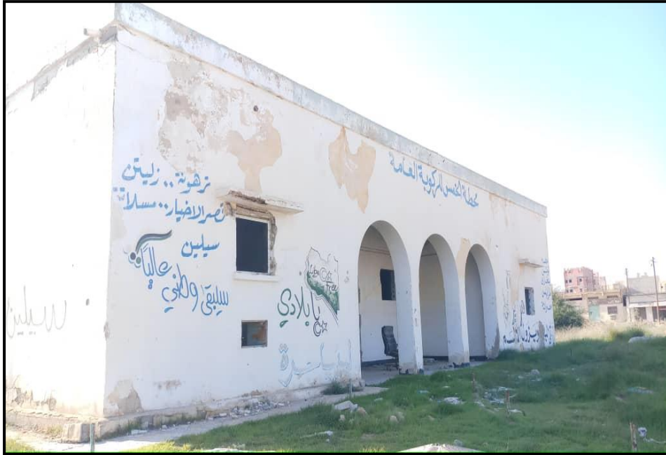
Fotoğraf 47. Hums Şehri Eski Toplu Taşıma İstasyonu
