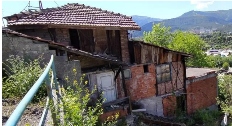
Şekil 2.22. Karabük Merkez, Öğlebeli Mahallesi, eğime konumlanmış farklı malzeme ve teknik ile inşa edilmiş bir konut örneği.
