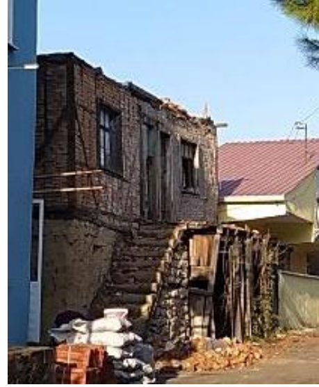
(c) 2022 yılında yapının yıkıntı durumu.
