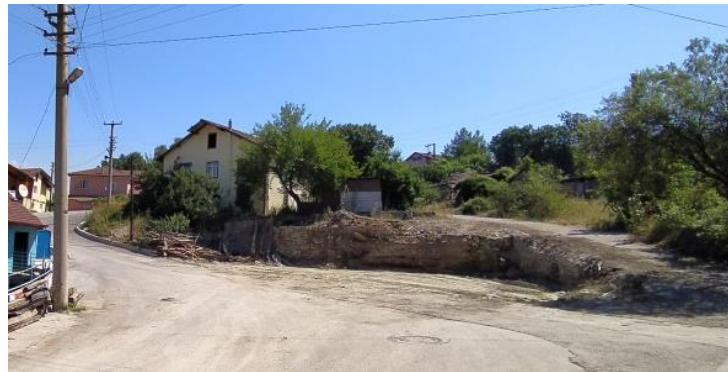
(c) 2022 yılında yapı yıkıldığında oluşan boşluk.
