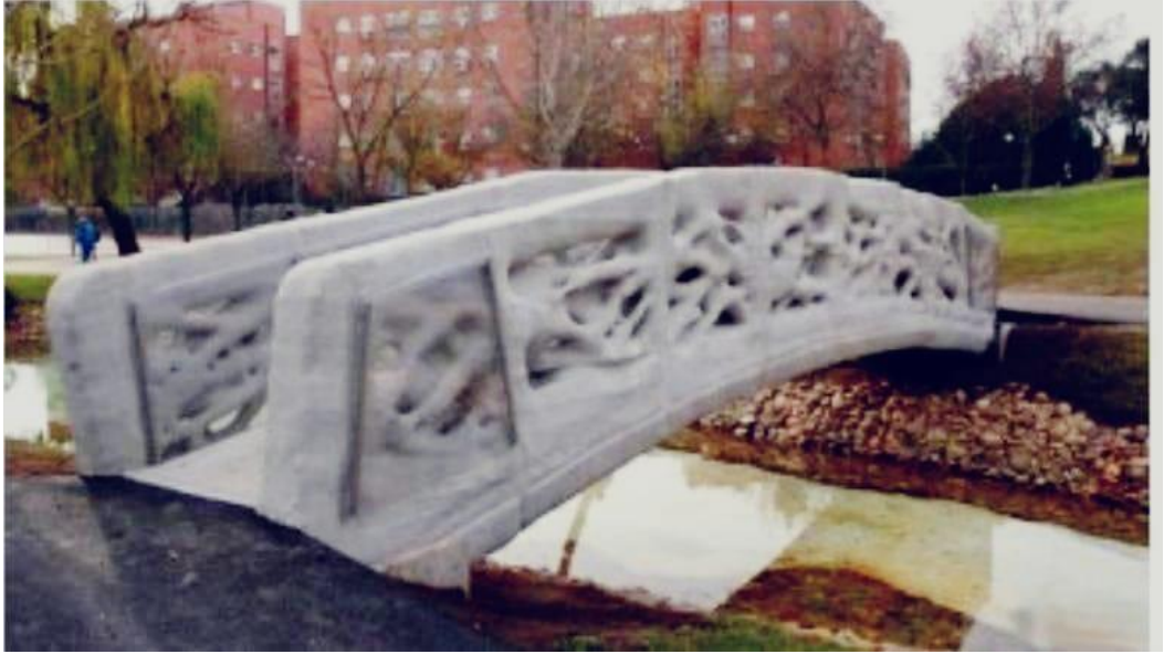
Şekil 3.1. Dünyanın ilk 3D baskılı köprüsü [16].
