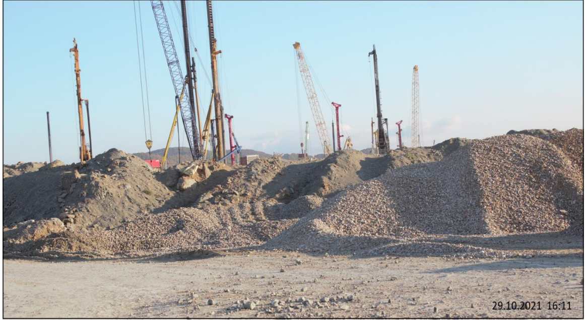
Fotoğraf 8. Filyos Limanı'nın Gerisinde Bulunan Endüstri Bölgesinden Bir Görünüm
