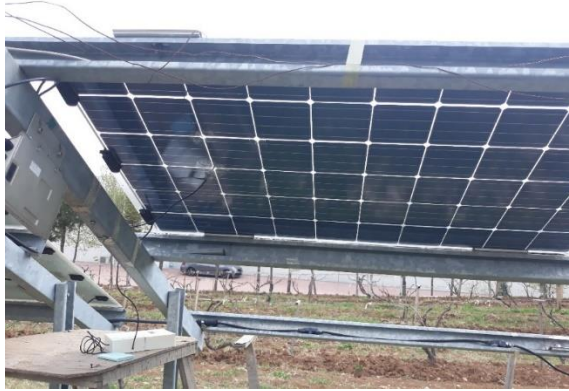
Şekil 6.16. Veri kaydedici düzeneğinin panele montajlanması.
