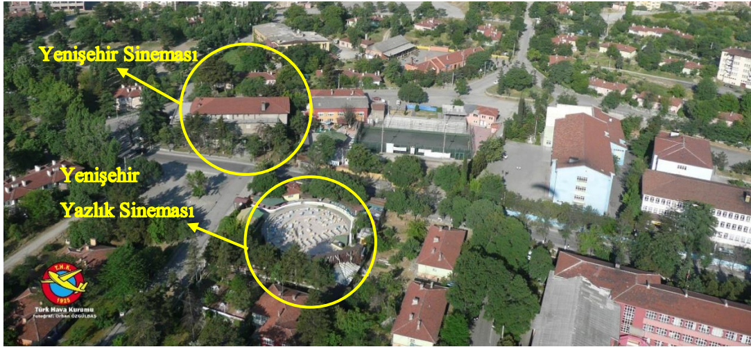
Şekil 4.96. Yenişehir Yazlık Sineması ve Yenişehir Sineması (THK Arşivi).
