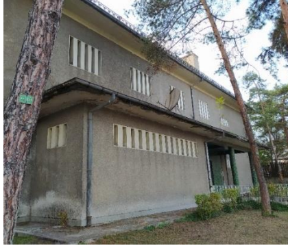
Şekil 4.112. Yenişehir Sineması yan cephe (Ulusoy Evlekoğlu Arşivi, 2020).
