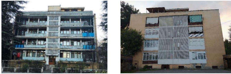
Şekil 4.62. Kübana Apartmanı ön ve arka cephe (Ulusoy Evlekoğlu Arşivi, 2020).
