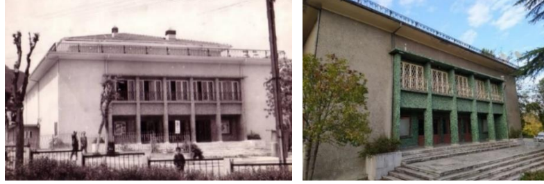
Şekil 4.114. Yenişehir Sineması ön cephe (KDÇF ve Ulusoy Evlekoğlu Arşivi, 2020).
