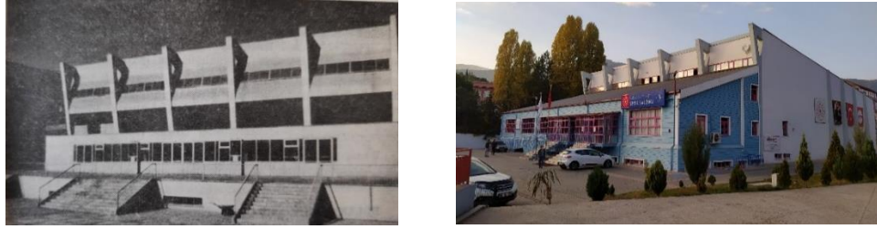
Şekil 4.103. İlk inşa edildiğinde (KDÇF Arşivi) ve günümüzde (Ulusoy Evlekoğlu Arşivi, 2020) Kapalı Spor Salonu.
