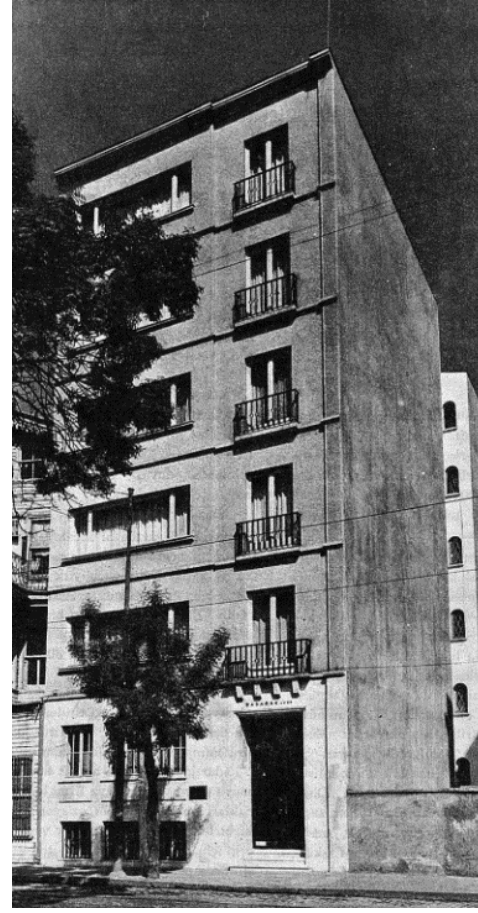
Şekil 4.66. Başaran Apartmanı (Binan, 1949: 50-53).
