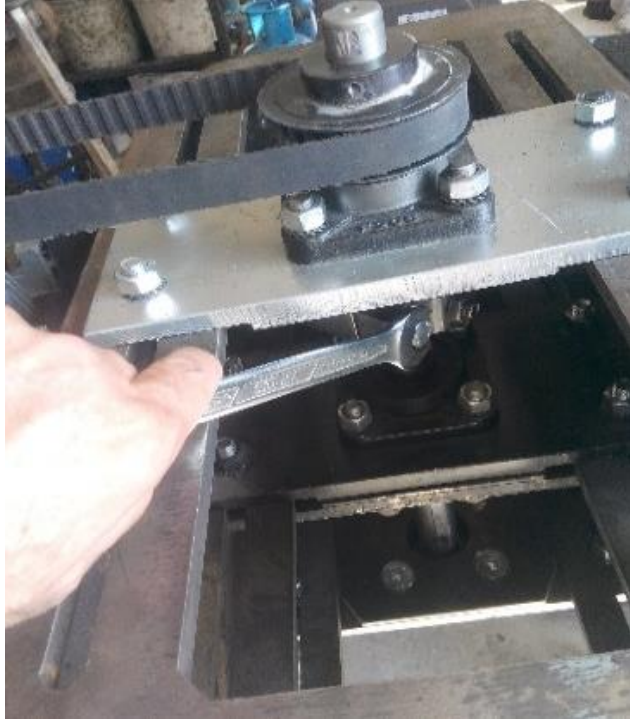
Şekil 2.23. Eksantrik kütleler ve hareket mekanizmalarının montaj işlemine ait bir görüntü.
