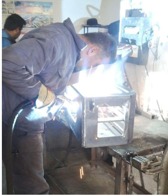
Şekil 2.17. Gövde sarsıcının ana gövdesinin kaynaklı birleştirilmesine ait bir görüntü.
