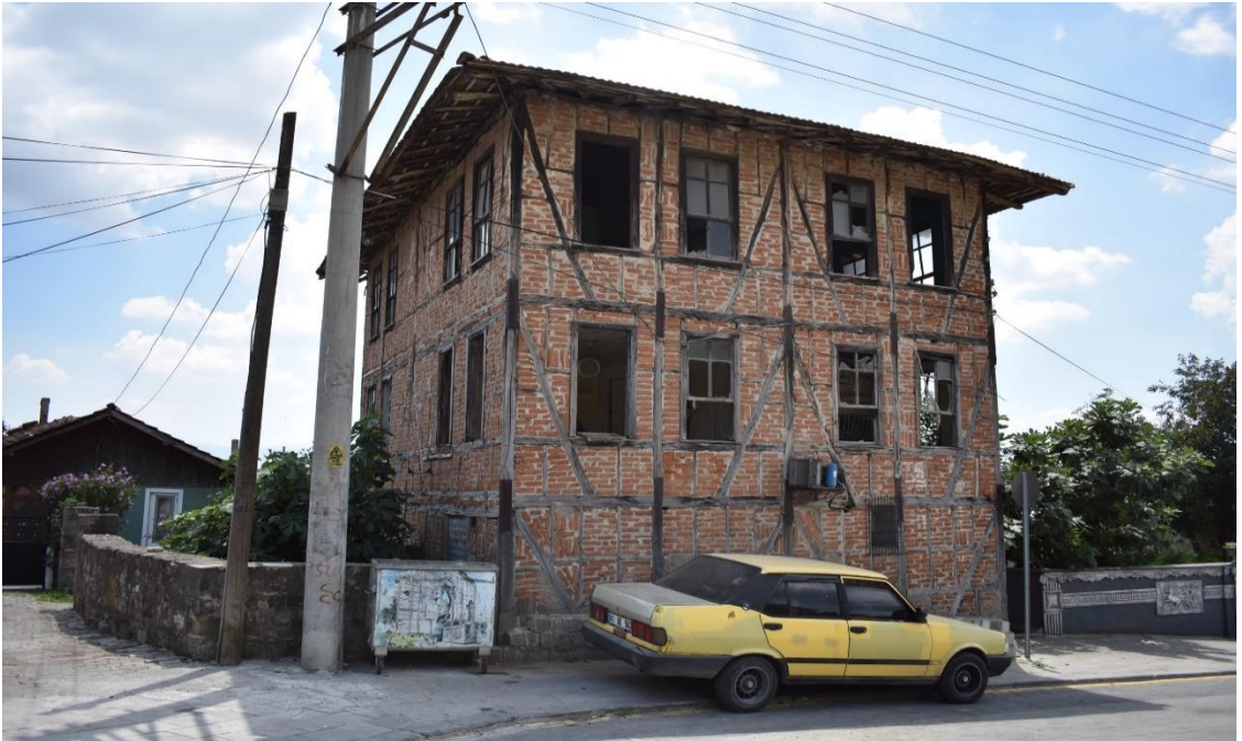
Fotoğraf 7. Bağbadi Tekniği ile Yapılmış (Hımış) Mesken (Konuralp).
