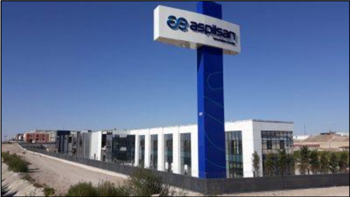
Fotoğraf 9: ASPİLSAN Pil ve Batarya Üretim Tesisleri (Kaynak: Aspilsan, 2022)
