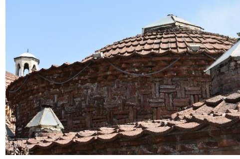
Fotoğraf 269: Bursa, Eski Kaplıca Hamamı, kubbe kasnağındaki hasır örgü düzenlemesi (Eylül 2021)
