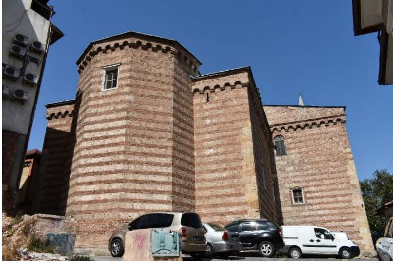
Fotoğraf 69: Güney cephesi, dışa taşkın harim duvarı (Eylül 2021)
