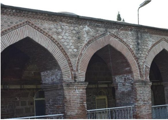
Fotoğraf 234: Bursa İpek Hanı, testere dişi kemer detayları (Mayıs 2022)
