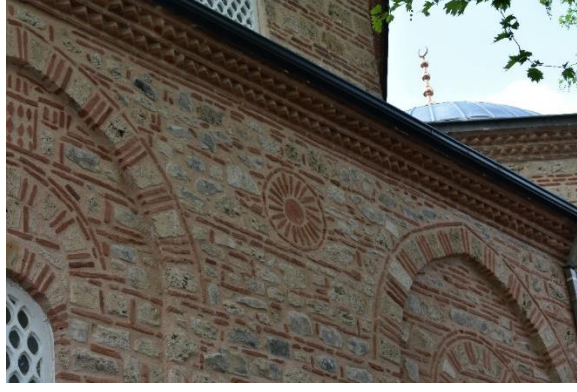
Fotoğraf 21: Batı cephesi güney eyvan duvarındaki tuğla tezyinat (Ekim 2021)
