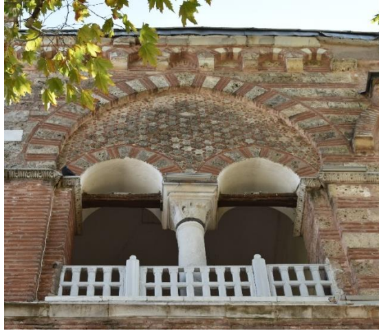
Fotoğraf 65: Üst kat revak kısmı, batı cephesi açıklığı (Eylül 2021)
