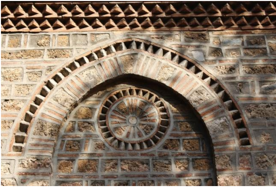
Fotoğraf 15: Batı eyvan duvarında niş içerisinde rozet (Ekim 2021)
