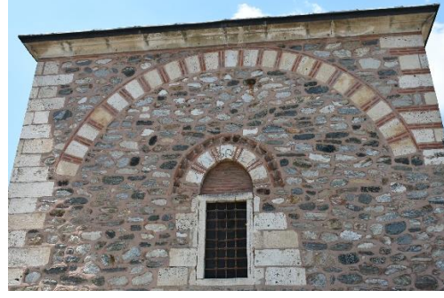
Fotoğraf 119: Doğu cephesi pencere süslemeleri (Mayıs 2022)
