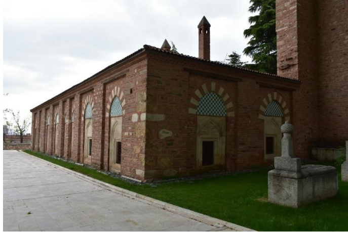
Fotoğraf 164: Güneybatı cephesinden görünüm (Mayıs 2022)
