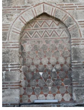
Fotoğraf 266: Acem Reis Cami, doğu duvarındaki pencere boyutundaki pano (Ekim 2021)
