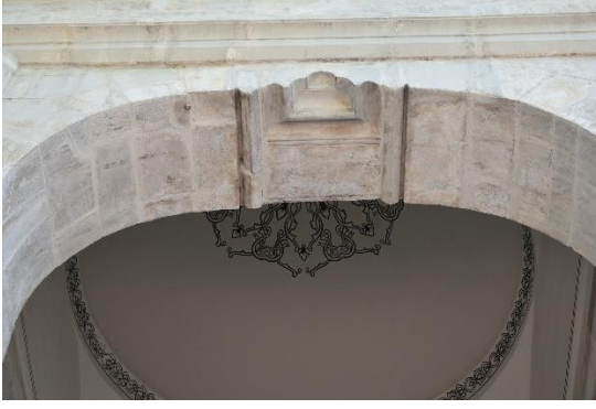
Fotoğraf 105: Revak kısmı Bursa kemeri (Mayıs 2022)
