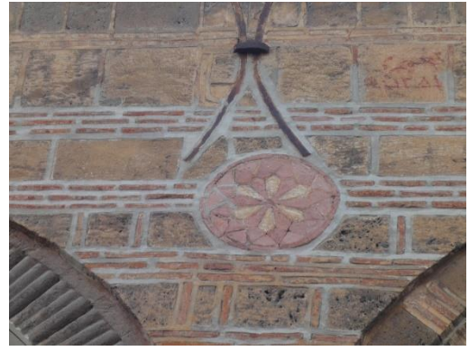
Fotoğraf 16: Revak kuzey cephesindeki rozet (Ekim 2021)
