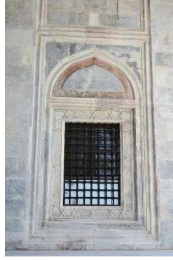
Fotoğraf 95: Kuzey cephe pencere örneği (Mayıs 2022)
