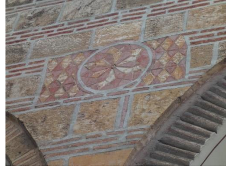
Fotoğraf 20: Revak kuzey cephesinde iki kemer arasındaki rozet (Ekim 2021)
