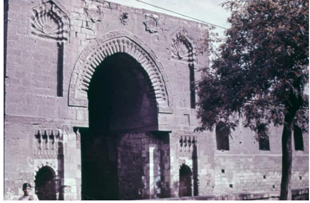
Fotoğraf 306: Kahire Baybars Cami, avlu giriş eyvanında dişli kemer 76
