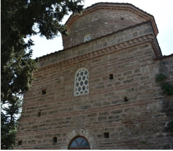
Fotoğraf 236: Kırğızlar/Kırkızlar Türbesi, testere dişi süsleme (Mayıs 2022)
