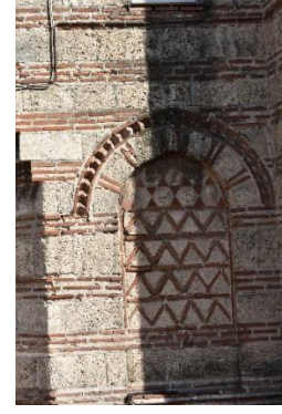
Fotoğraf 241: Acem Reis Cami, batı cephesi (Ekim 2021)
