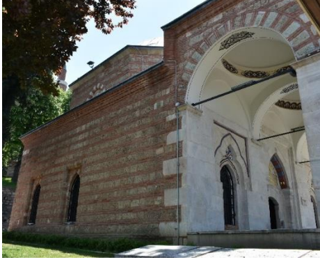
Fotoğraf 122: Doğu cephesi (Mayıs 2022)
