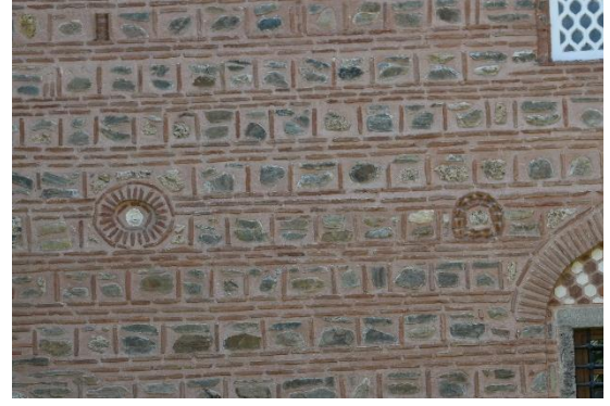
Fotoğraf 189: Ana derslik eyvanı doğu cephesindeki rozet süslemeler (Mayıs 2022)
