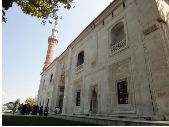
Fotoğraf 126: Kuzey giriş cephesi (Ekim 2021)
