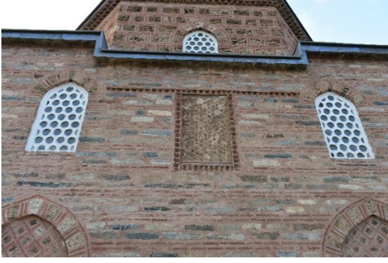
Fotoğraf 240: Sitti Hatun Cami, güney cephesi (Mayıs 2022)
