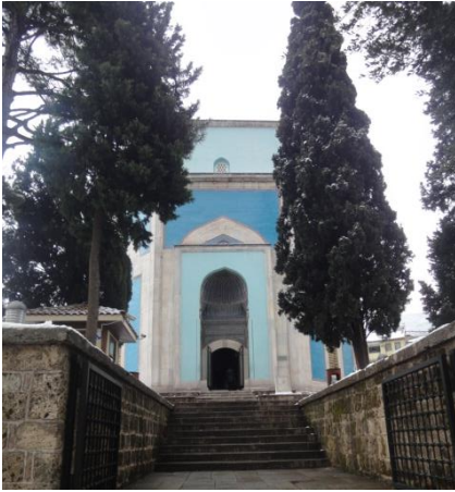
Fotoğraf 149: Kuzey giriş cephesi (Ekim 2021)
