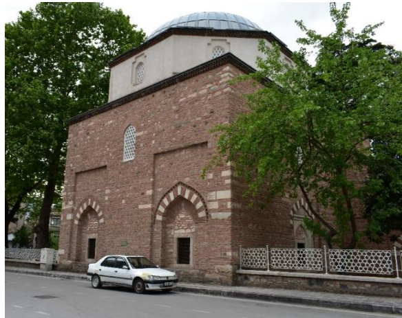
Fotoğraf 167: Derslik eyvanı güney cephesi (Mayıs 2022)
