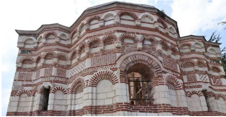
Fotoğraf 270: Misivri-Nesebar (Bulgaristan). Sv. Ivan Aleiturgetos kilisesi, doğu cephesi 67
