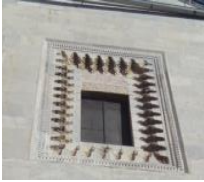
Fotoğraf 318: Selçuk İsa Bey Cami, batı cephesinden bir pencere süslemesi (Mayıs 2016)
