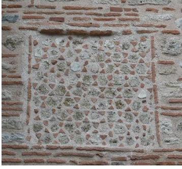
Fotoğraf 260: Orhan Cami, güney duvarındaki pano (Ekim 2021)
