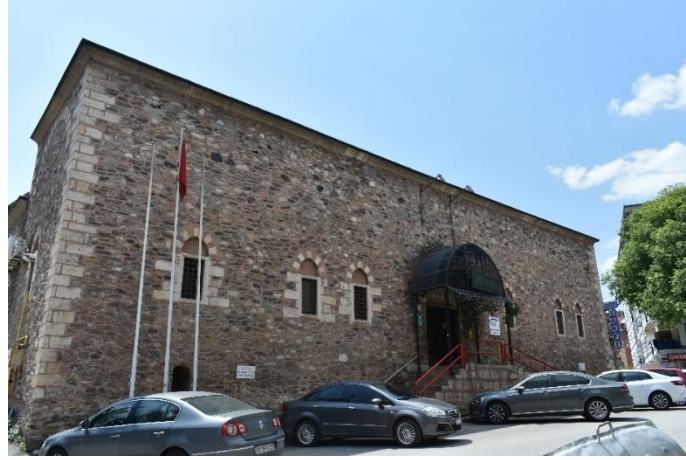
Fotoğraf 117: Kuzey giriş cephesi (Mayıs 2022)
