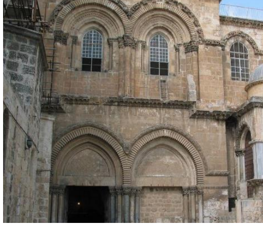
Fotoğraf 304: Kudüs Kutsal Mezar Kilisesi, giriş cephesindeki dişli kör kemerler 75
