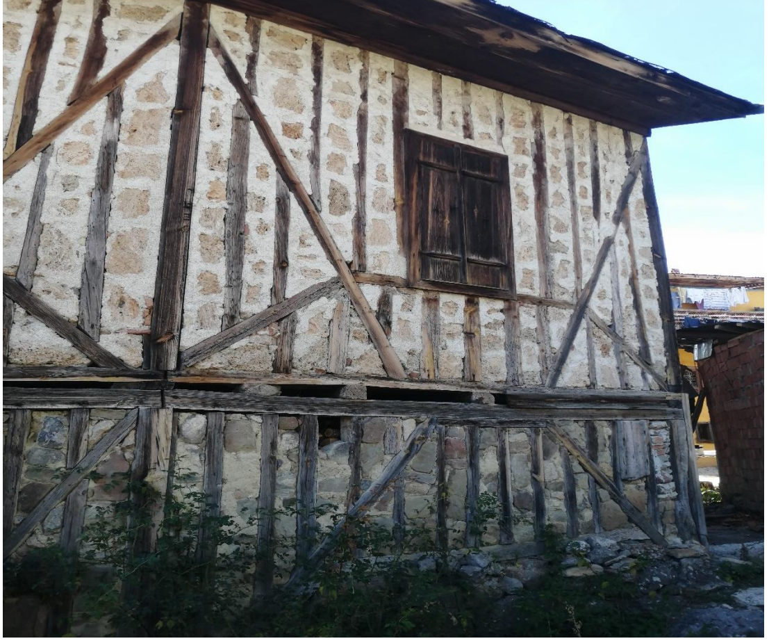
Şekil 2.4. Ahşap çerçevesel duvar.
