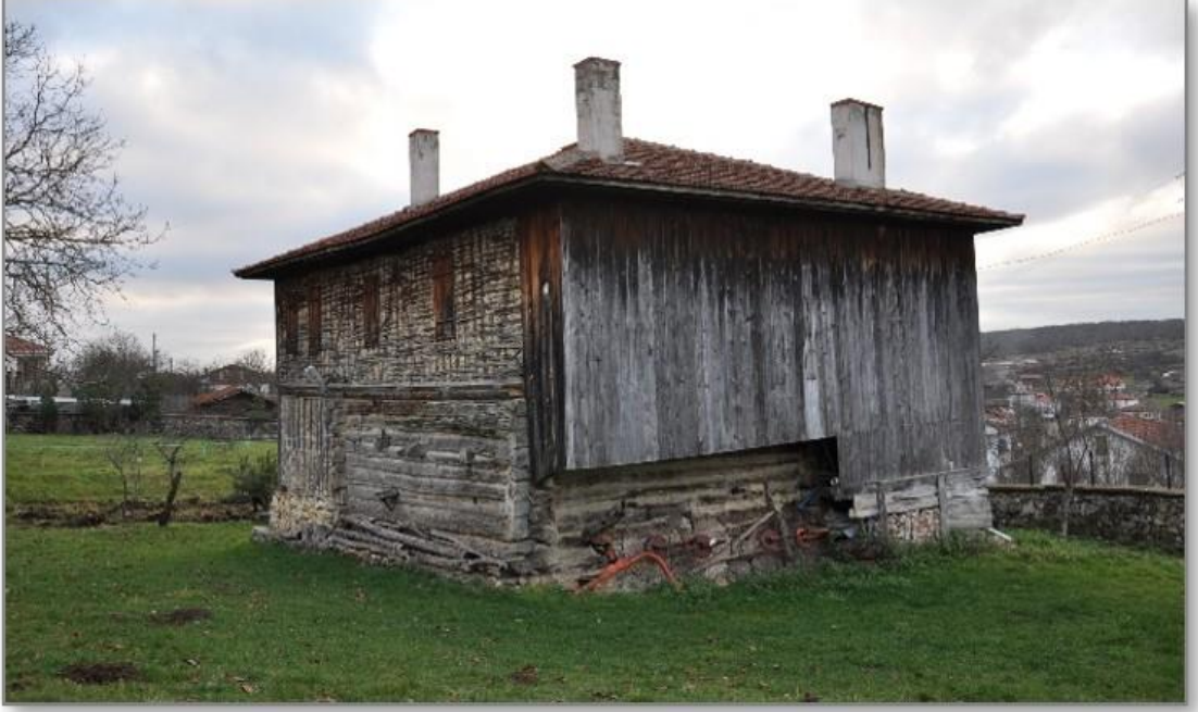
Şekil 4.3. Örnek yapının sağ yan ve arka cephe görünüşü [27].
