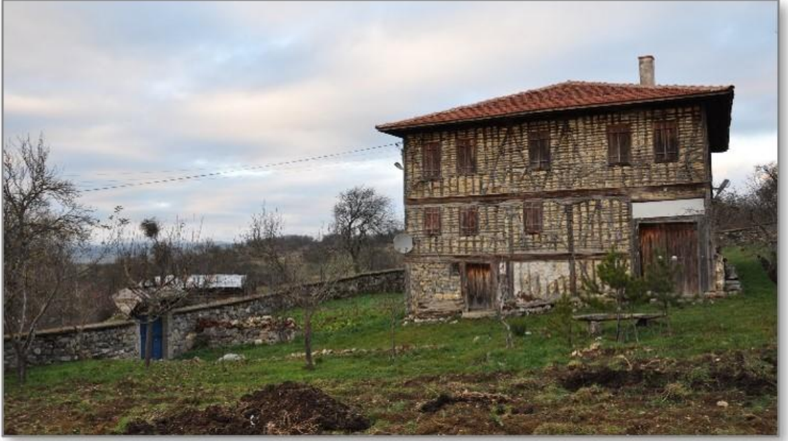
Şekil 4.1. Örnek yapının ön cephe görünüşü [27].
