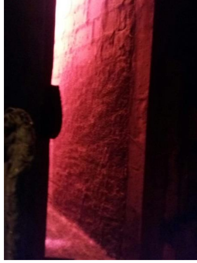
Şekil 3.6. Sıfır genişmeli tuğla ile tamir edilmiş fırın duvarı.
