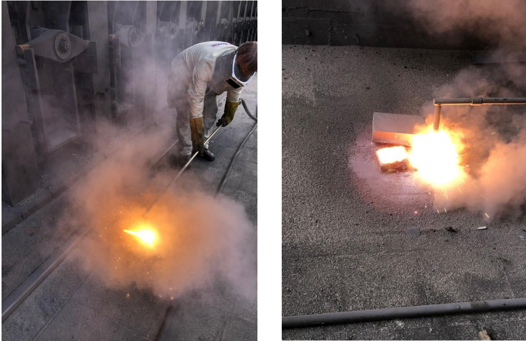
Şekil 4.1. Deney numunelerine yapılan seramik kaynak uygulaması.
