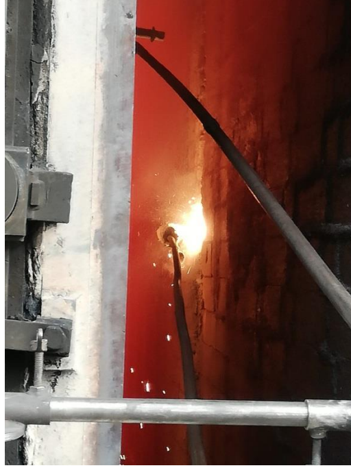
Şekil 3.5. Fırın içi seramik kaynak uygulaması.
