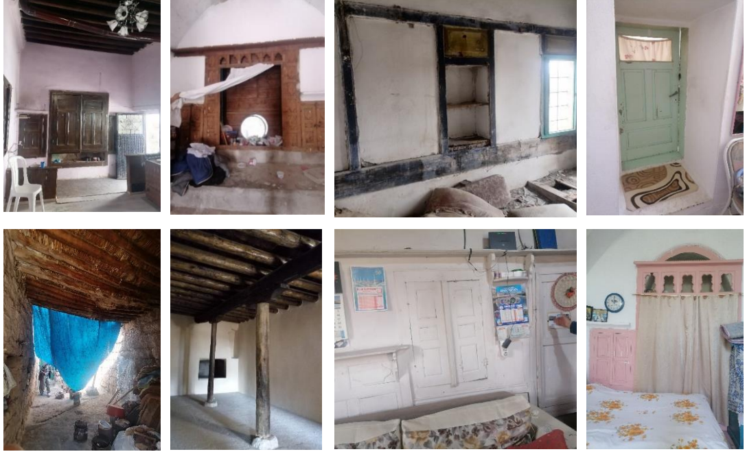
Şekil 4.189. İncesu geleneksel evlerinin iç mekânında ahşap kullanımı
