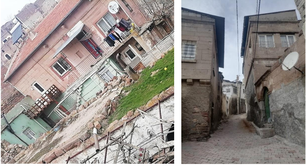
Şekil 4.180. Çatısına sonradan meyil verilen yapı örnekleri
