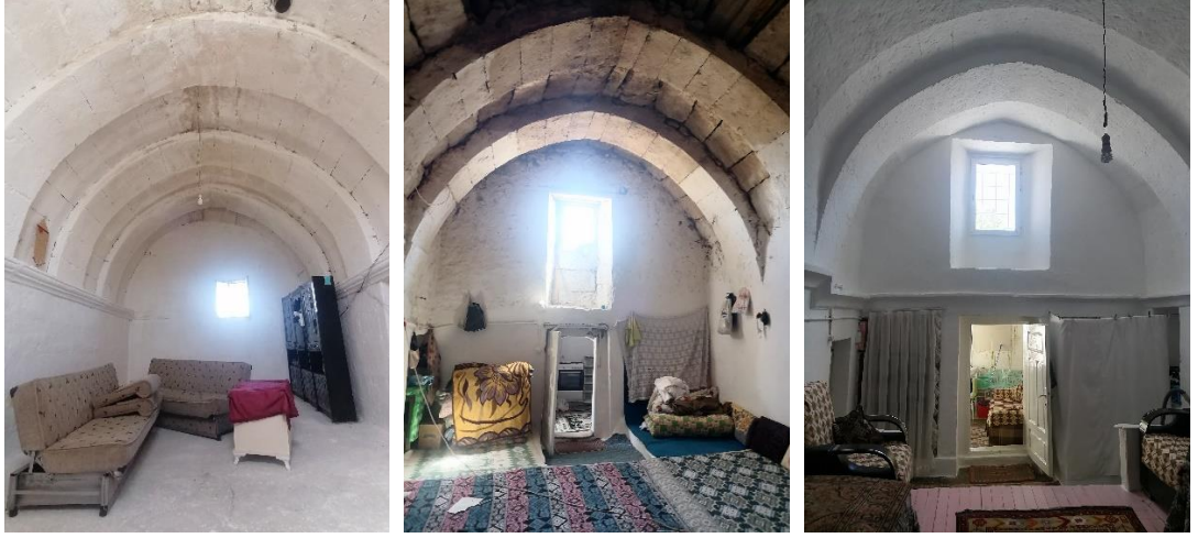
Şekil 4.121. İncesu geleneksel evlerinde tonozlu tavan örnekleri
