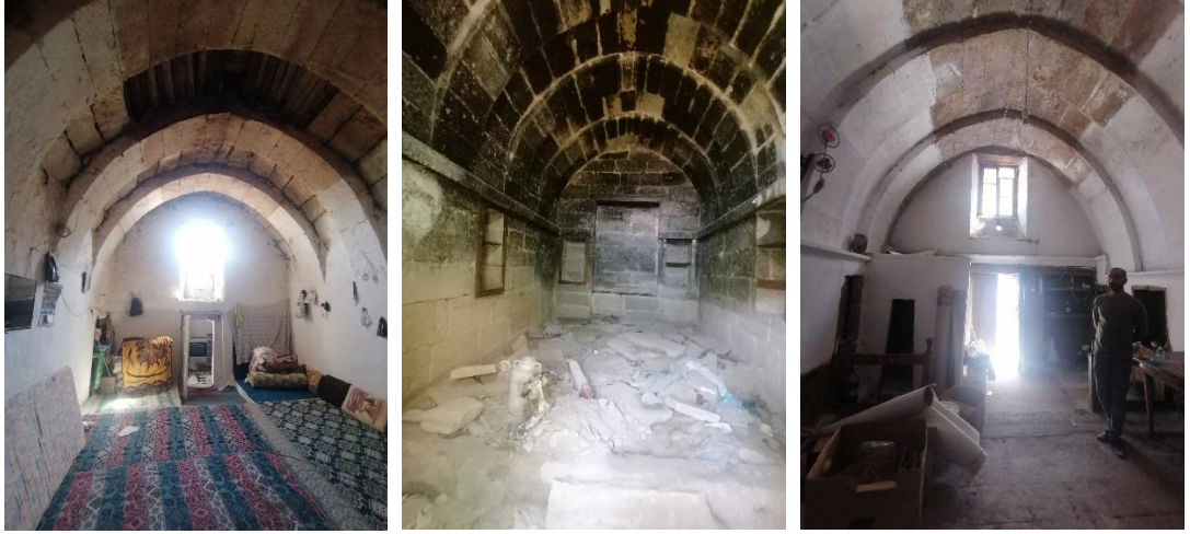
Şekil 4.143. Tonuzlu tavan örnekleri
