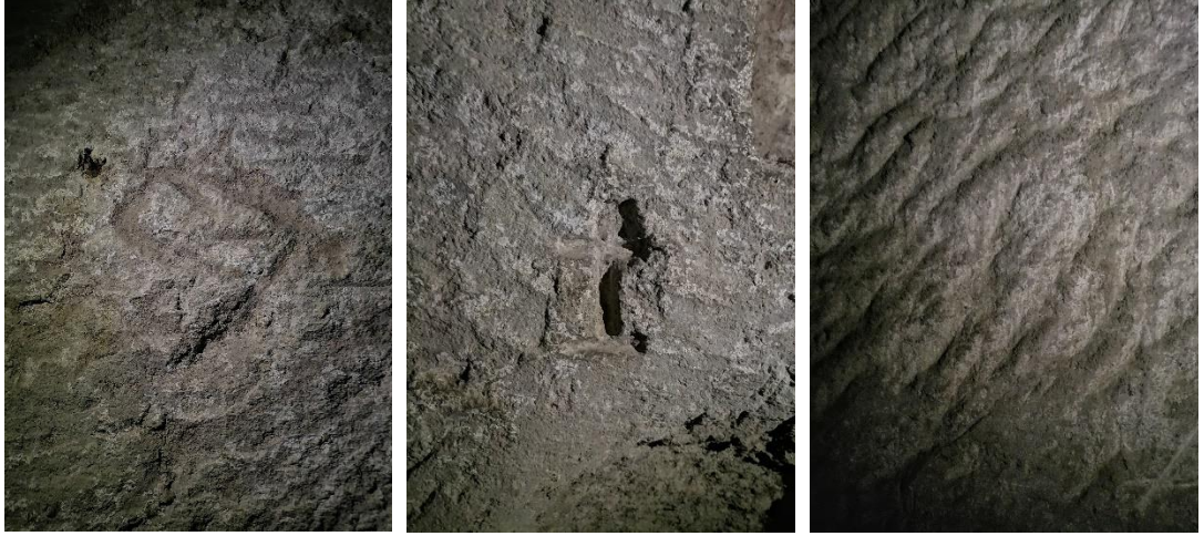
Şekil 4.62. Bodrum kat duvarlarından detaylar
