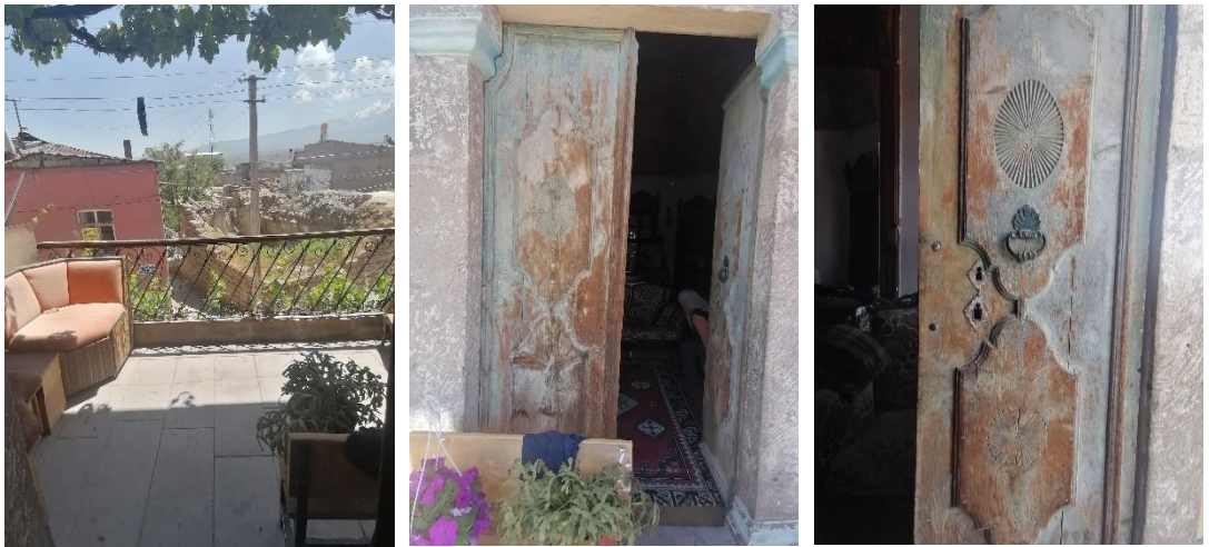
Şekil 4.44. Mestav konağı balkonu
