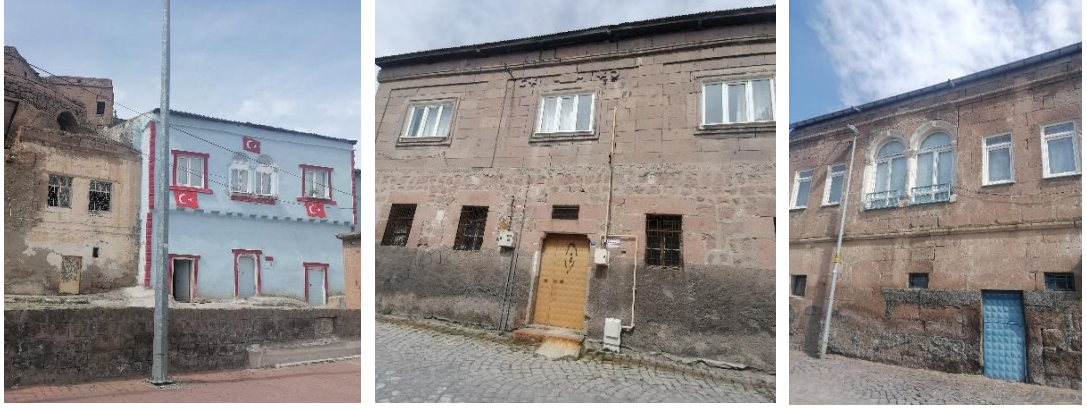
Şekil 5.7. Ahşap pencerelerin yerini alan PVC pencereler
