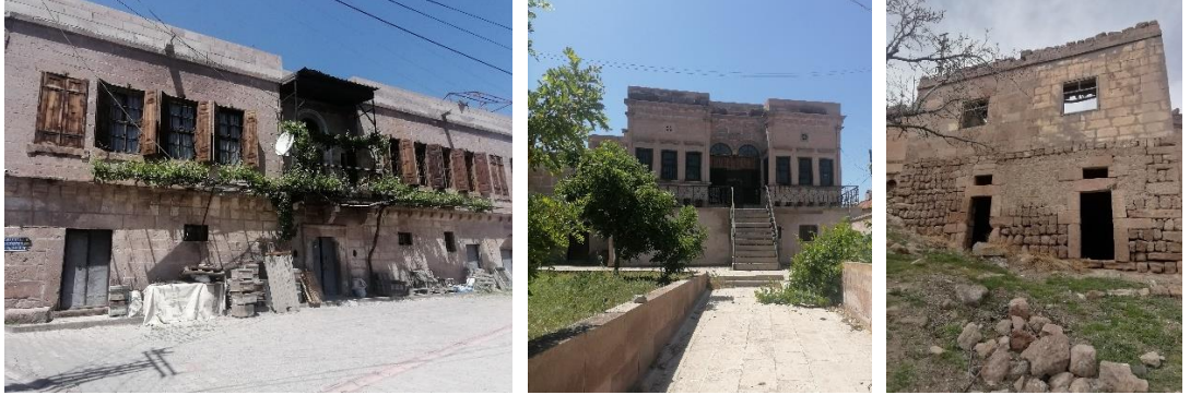
Şekil 4.131. İncesu geleneksel evlerinde duvar örnekleri
