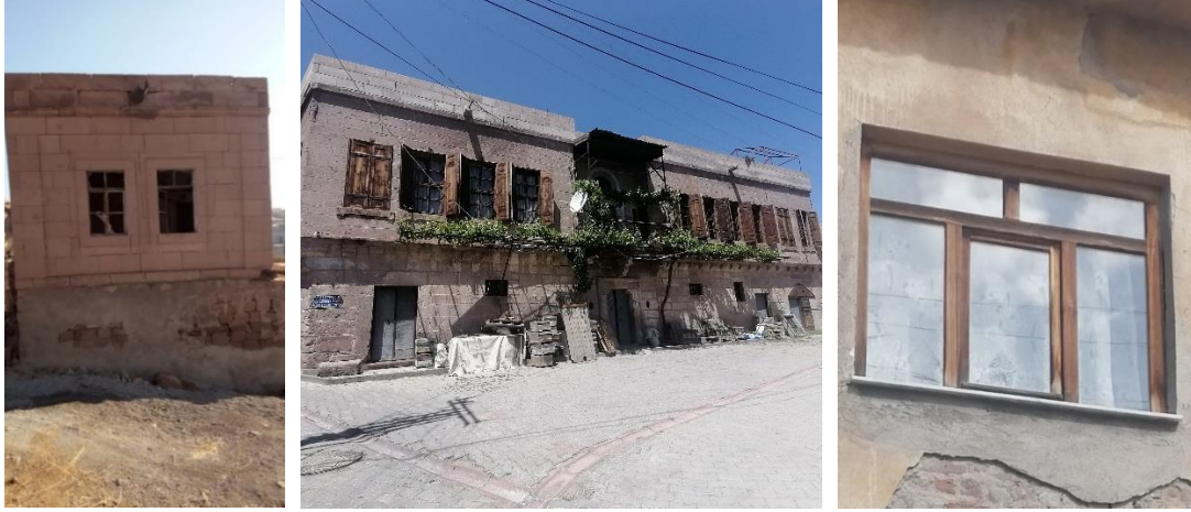
Şekil 4.170. İki parçalı pencere örnekleri
