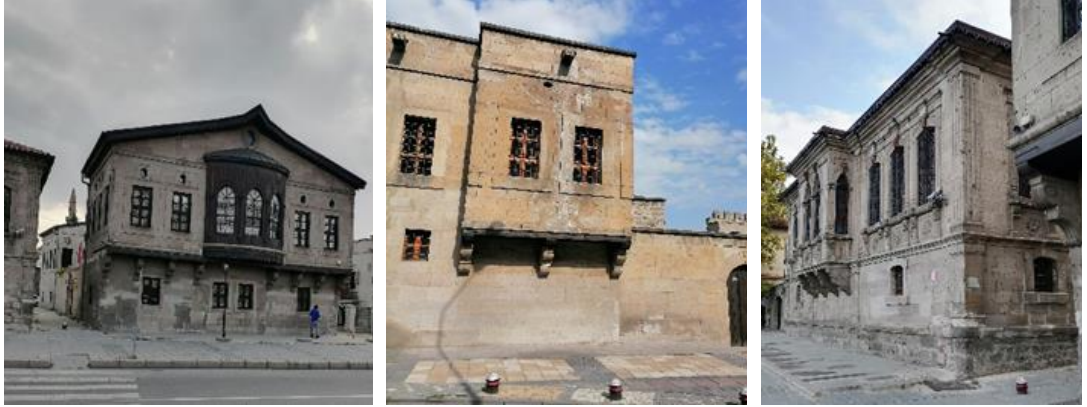
řekil 3.28. Geleneksel Kayseri evlerinde cephe düzeni
