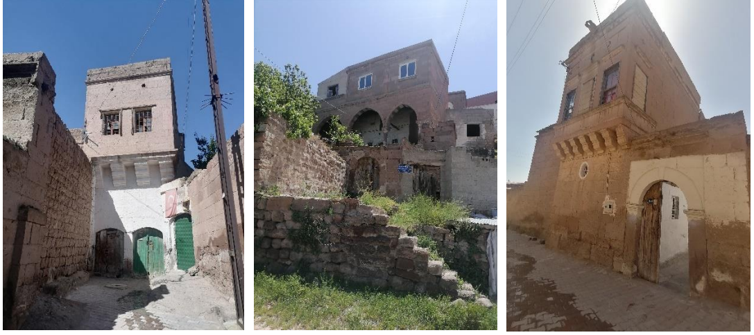
Şekil 4.132. İncesu geleneksel evlerinde duvar örnekleri
