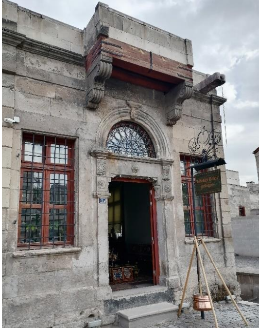
Şekil 3.7. Setenönü mahallesinde tarihi Ermeni evi giriş kapısı
