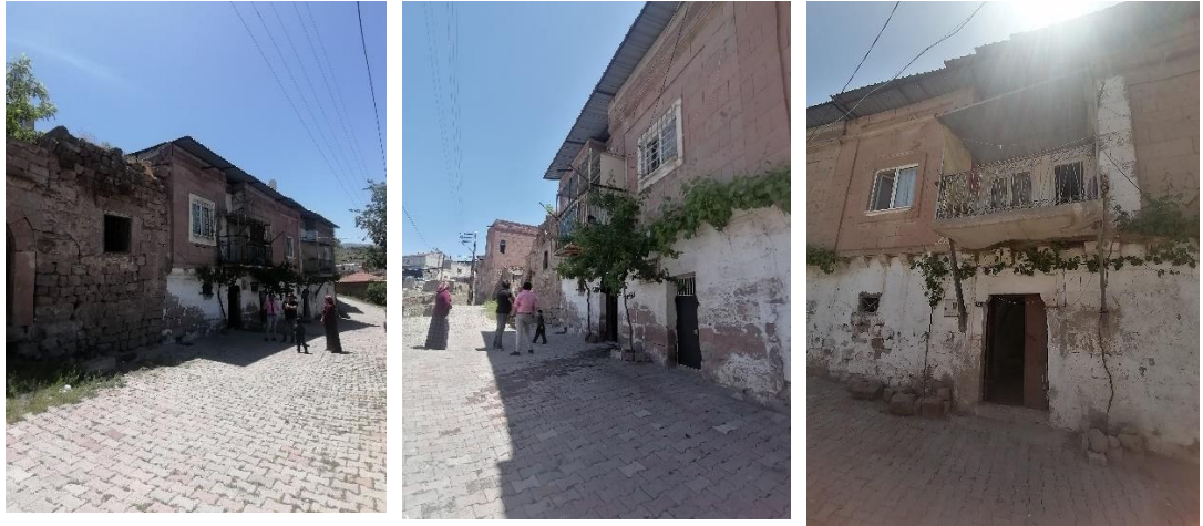
Şekil 4.79. Kaçmaz evinden genel görünüm
