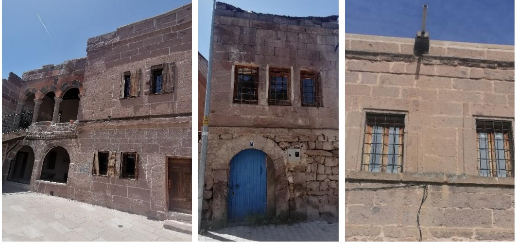
Şekil 4.171. Tek parçalı pencere örnekleri
