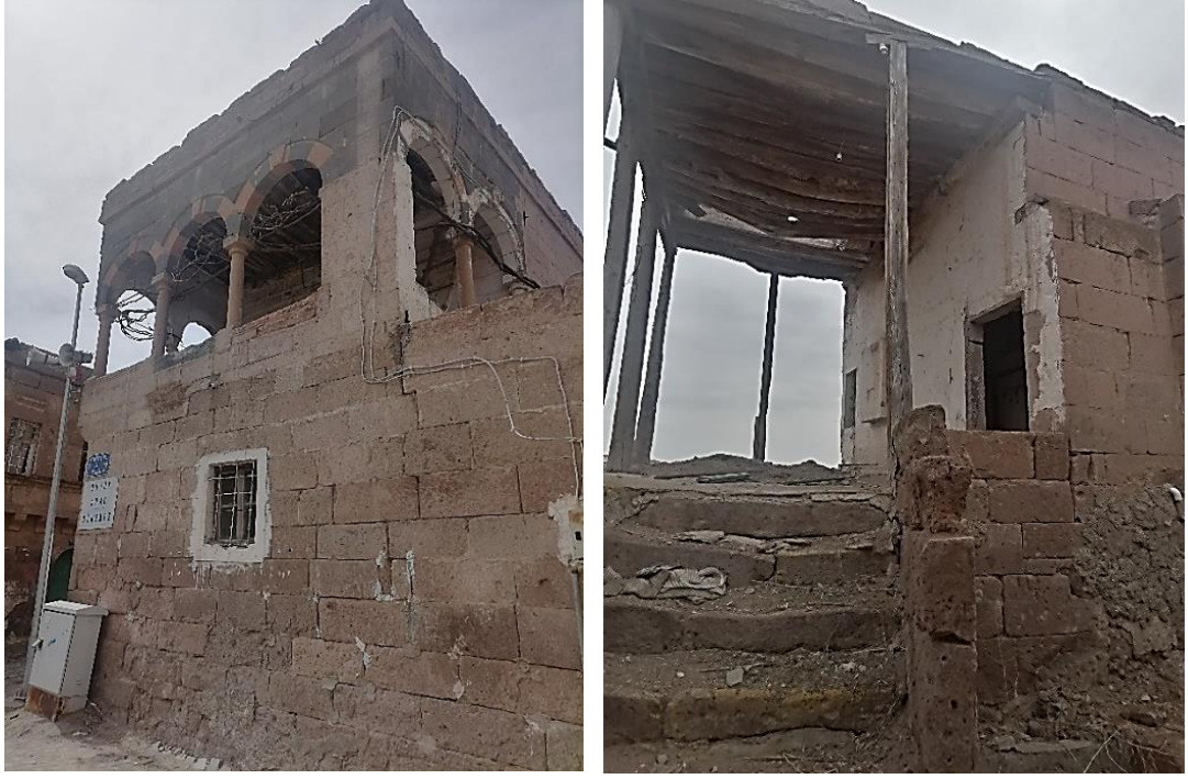
Şekil 4.176. Oturma mekânı oluşturulan balkonlar
