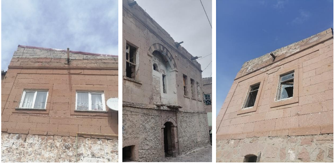
Şekil 5.9. İncesu’da özgün dokusu korunamayan çörlenler
