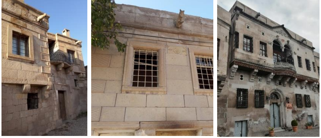
Şekil 3.36. Geleneksel Kayseri evlerinde çörten örnekleri
