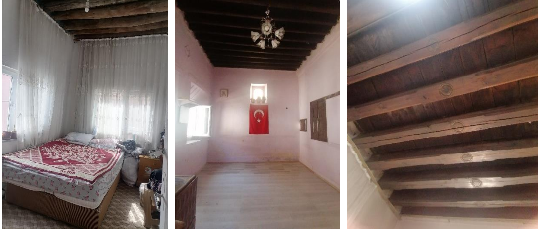
Şekil 4.120. İncesu geleneksel evlerinde ahşap tavan örnekleri
