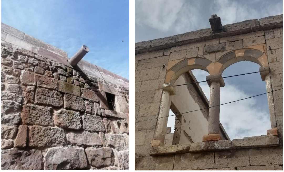
Şekil 4.181. İncesu evlerinde çörten örnekleri
