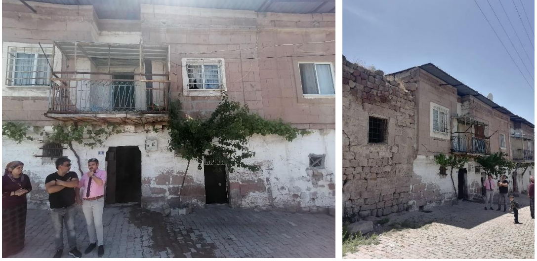
Şekil 4.80. Kaçmaz evinden genel görünüm
