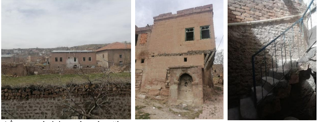
a) İncesu evlerinin çatılarında tuğla kullanımı
