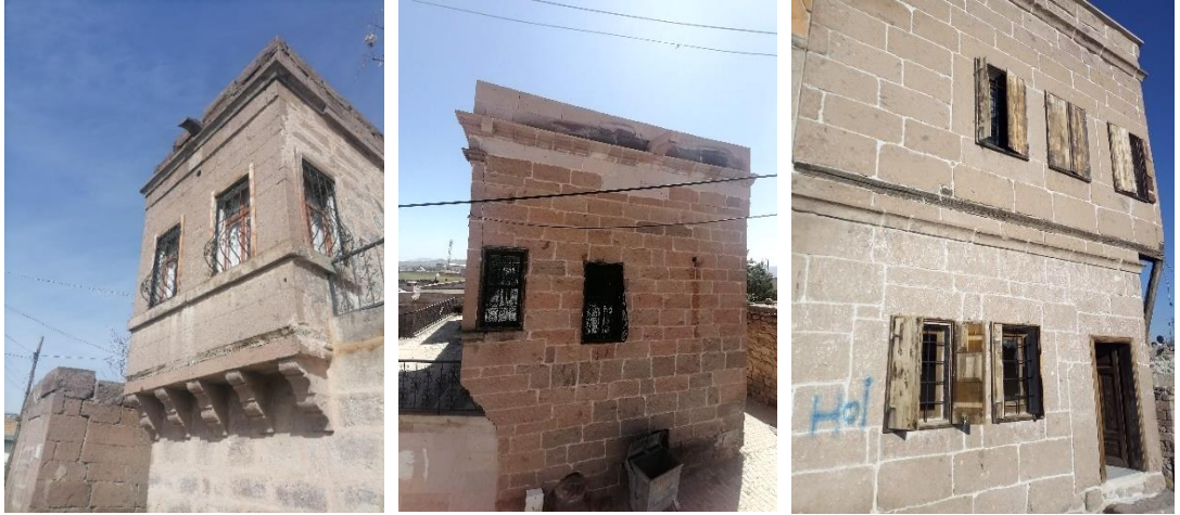
Şekil 4.169. İncesu evlerinde pencerelerde parmaklık ve kepenk örnekleri
