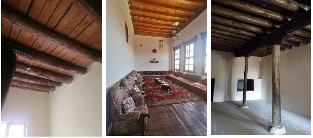
Şekil 4.142. İncesu geleneksel evlerinde ters tavan örnekleri
