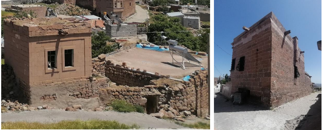
Şekil 4.4. İncesu çatı ve çörten örnekleri
