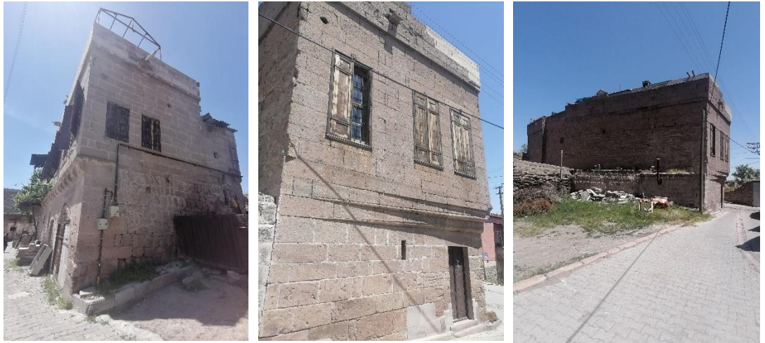
Şekil 4.35. Mestav konağından genel görünüm
