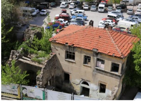
Gavremoğlu konağı restorasyon öncesi genel görünümü (İnternet 18)
