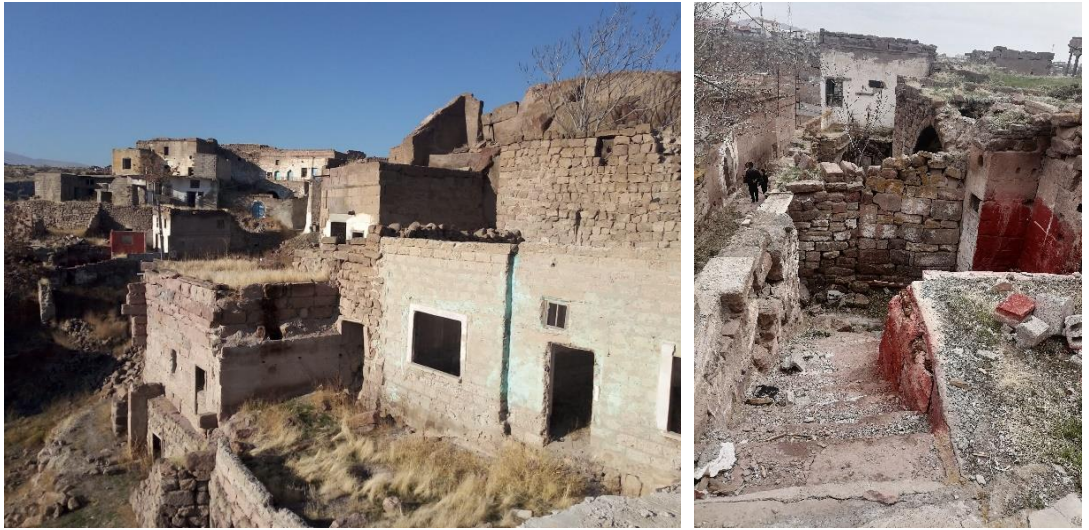
Şekil 4.178. İncesu'da düz toprak damlı çatı örnekleri
