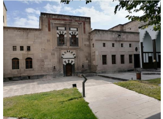
Şekil 3.15. Güpgüpoğlu Konağı haremlik bölümü
