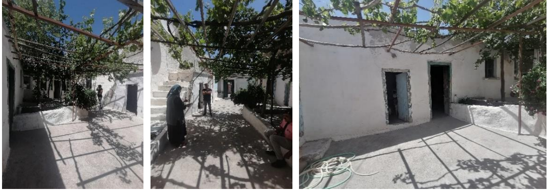
Şekil 4.52. Rukane Mat evinden genel görünüm
