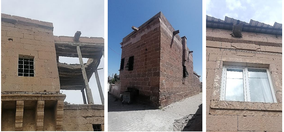
Şekil 4.182. İncesu evlerinde çörten örnekleri
