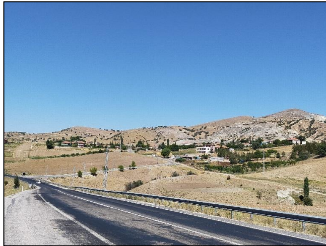
Şekil 4.55. Obruk yeni yerleşimi.
