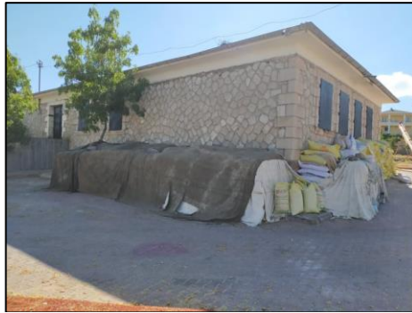
Şekil 4.10. Emmiler okul binası.
