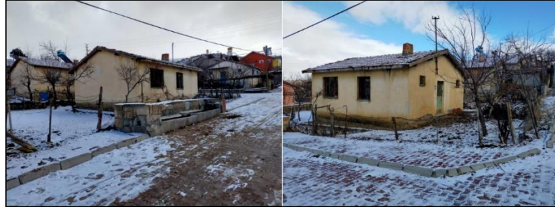
Şekil 4.63. Obrukta yapılan afet konutları.
