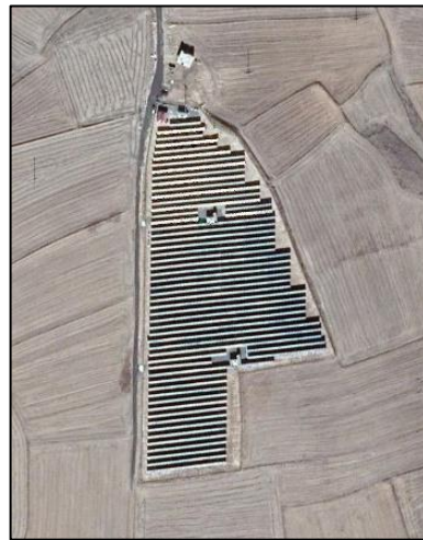
Şekil 3.10. Emmiler Güneş enerji santrali [3].
