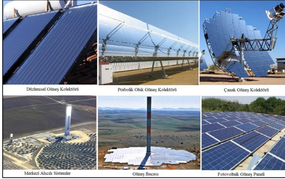
Şekil 3.11. Isıl ve elektrikselsel güneş uygulamaları [36].
