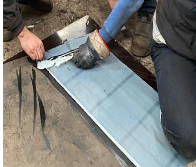
Şekil 3.33. Ara kauçuğun yapıştırılması
