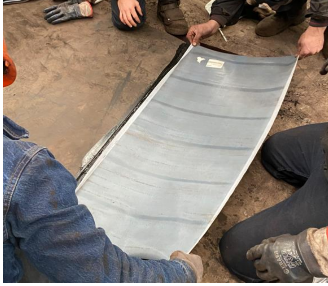
Şekil 3.32. Ara kauçuk atılması
