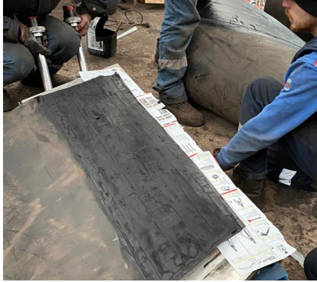
Şekil 3.36. Alt travers ile bant arasına gazete kâğıdı yerleştirilmesi
