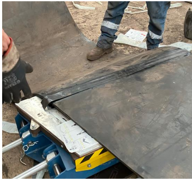
Şekil 3.37. Bant uçlarının hizalanarak birleştirilmesi
