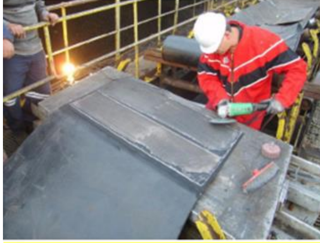
Şekil 3.2. Konveyör bantların soğuk vulkanizasyon ile eklenmesi [10].
