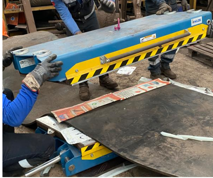
Şekil 3.40. Üst traverslerin yerleştirilmesi
