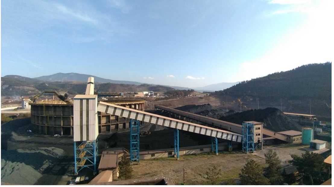
Şekil 2.2. Kömür hazırlama tesisi genel görünümü.
