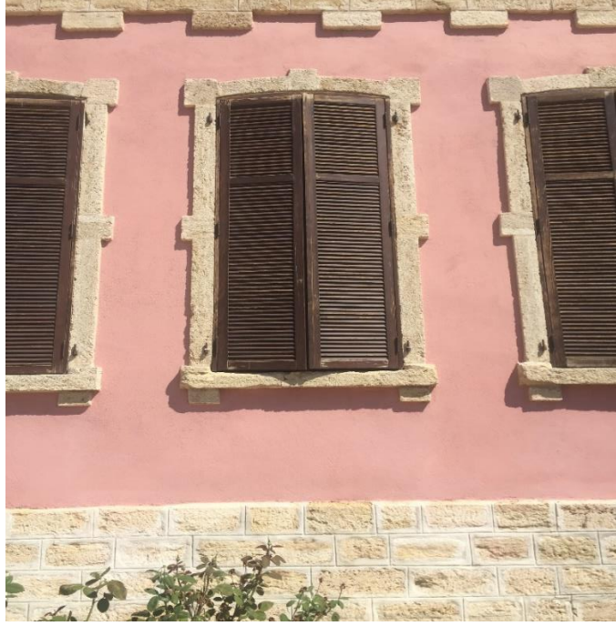
Şekil 3.68. Ana Bina (A Blok) pencere detayı (Şar, 2022).
