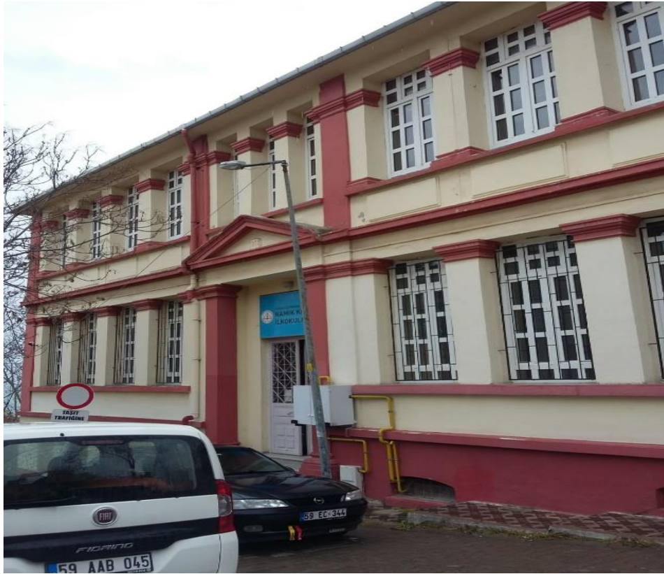
Şekil 3.171. Doğu cephesi (Şar, 2020).
