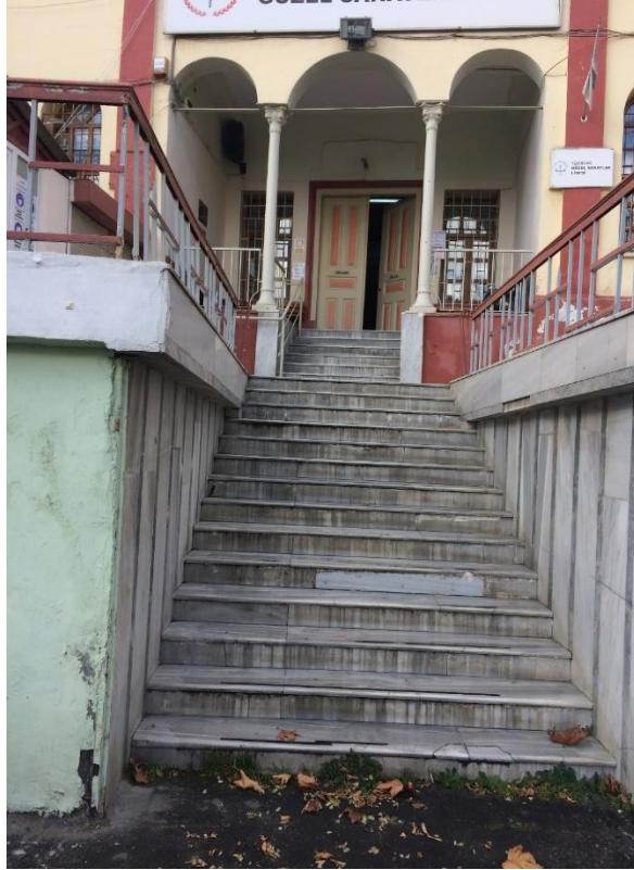
Şekil 3.97. Bina girişi (Şar, 2020).
