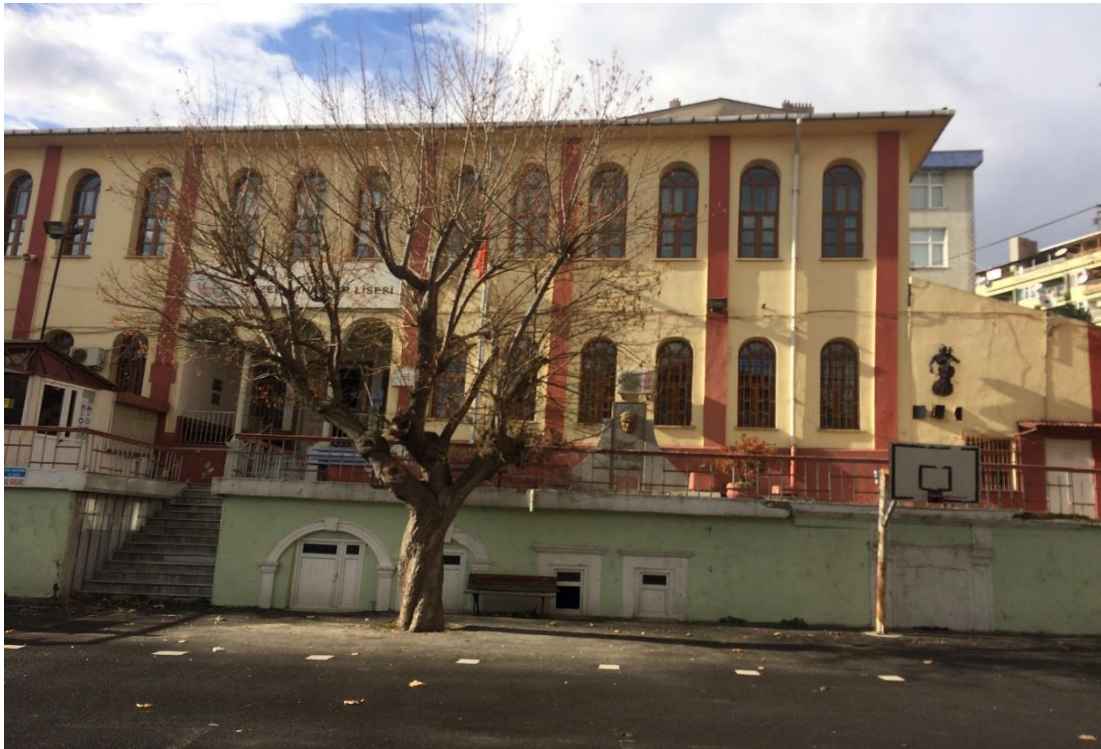
Őekil 3.111. İkinci bodrum kat cephesi, depo ve çeŐme (Őar, 2020).
