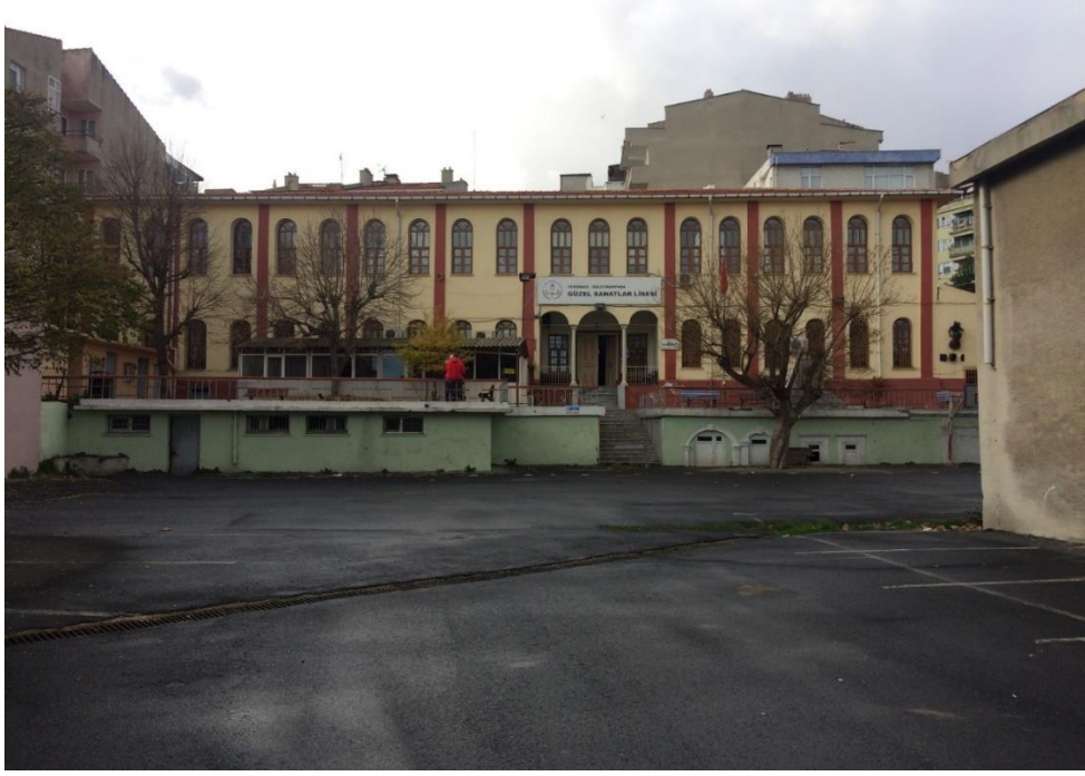
Şekil 3.113. İnönü Ortaokulu doğu cephesi (Şar, 2020).
