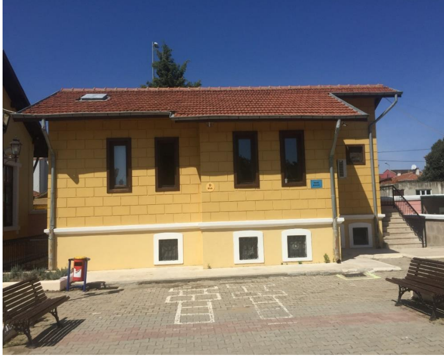
Şekil 3.70. İdare Binası (D Blok) doğu cephesi (Şar, 2022).
