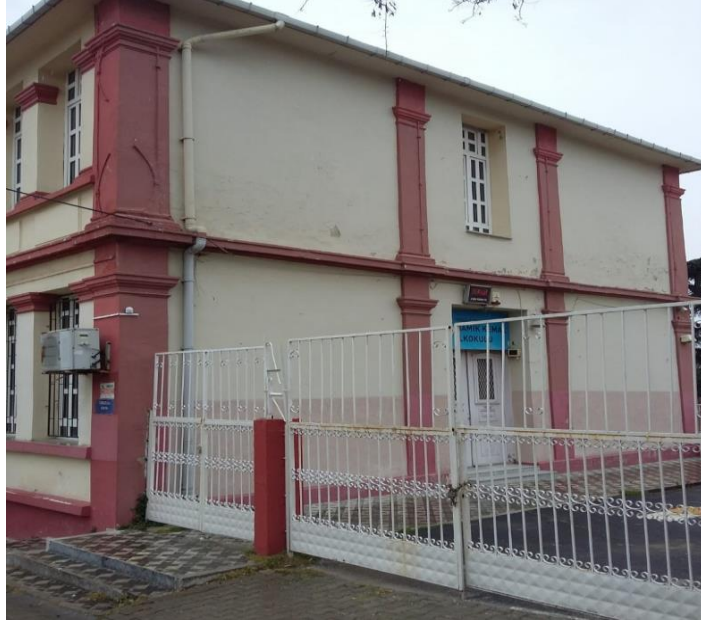
Şekil 3.176. Kuzeydoğu cephesi (Şar, 2020).
