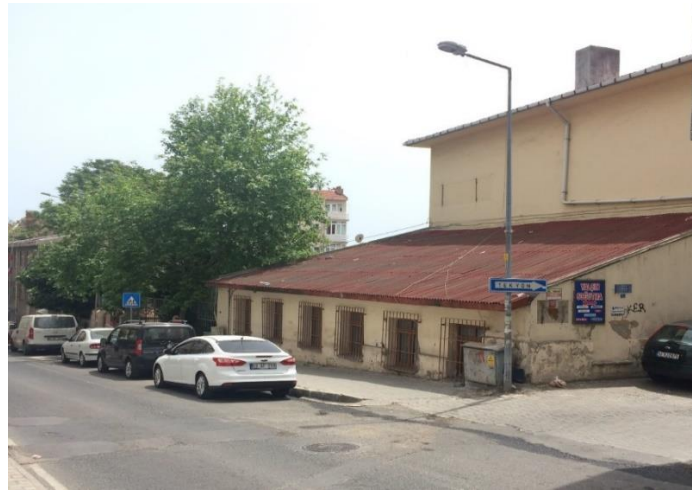
Şekil 3.123. Kuzey cephesi (Şar, 2020).
