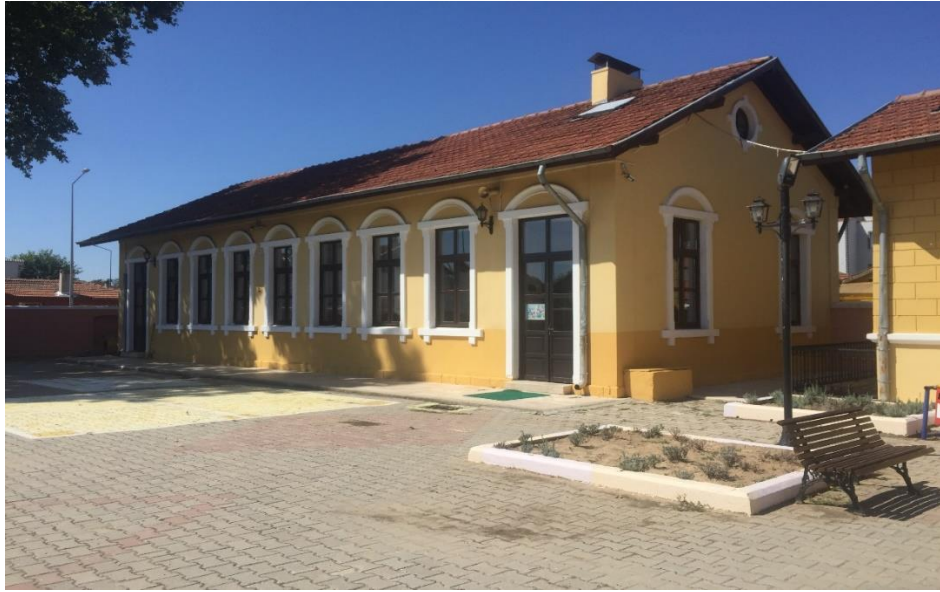
Şekil 3.71. Özgün haliyle yemekhane olarak kullanılan yapının (C Blok) giriş cephesi (Şar, 2022).
