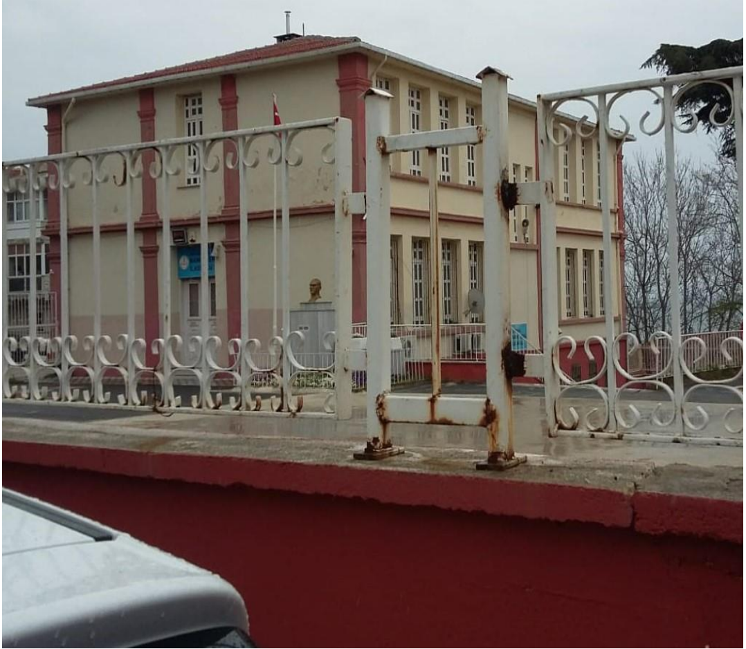
Şekil 3.175. Kuzeybatı cephesi (Şar, 2020).
