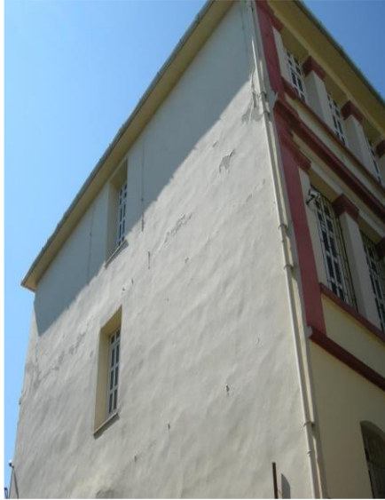
Şekil 3.177. Güney cephesi (Şar, 2020).
