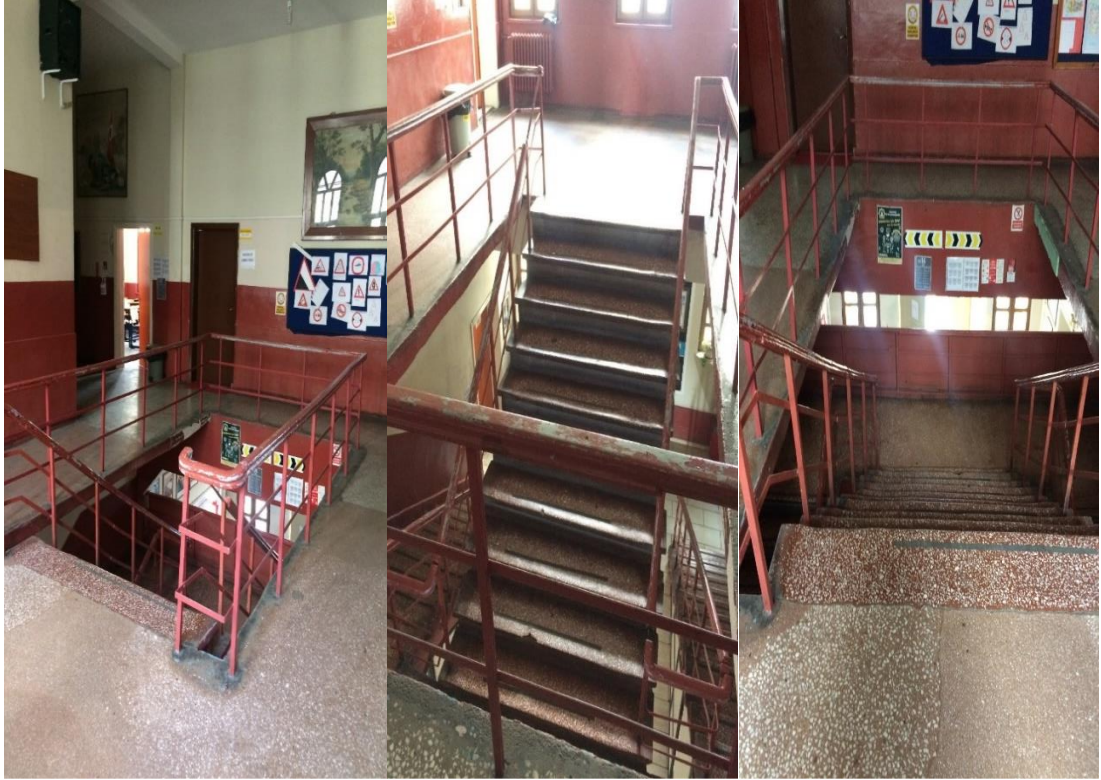
Şekil 3.103. Birinci kat merdiven holü (Şar, 2020).
