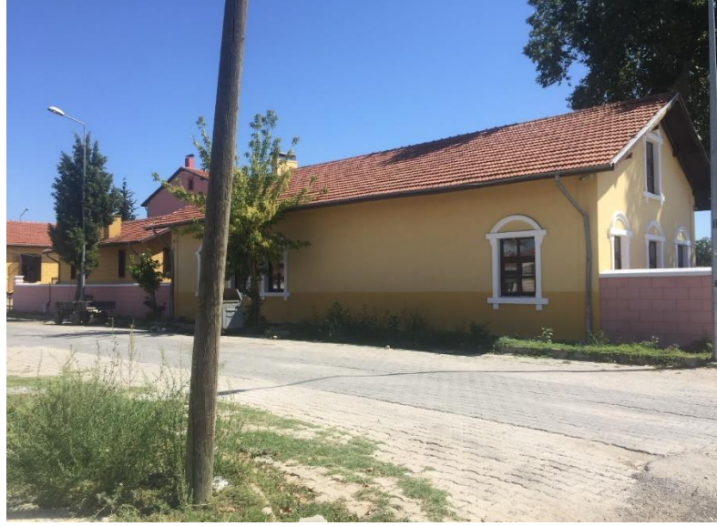
Şekil 3.72. C Blok batı cephesi (Şar, 2022).
