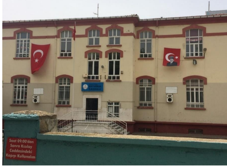
Şekil 3.86. Ertuğrul İlkokulu doğu cephesi (Şar, 2020).
