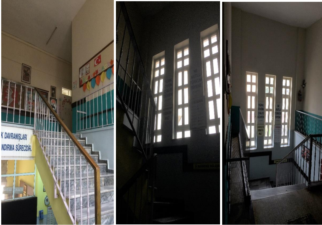
Şekil 3.158. Normal kata çıkan merdivenler (Şar, 2021).
