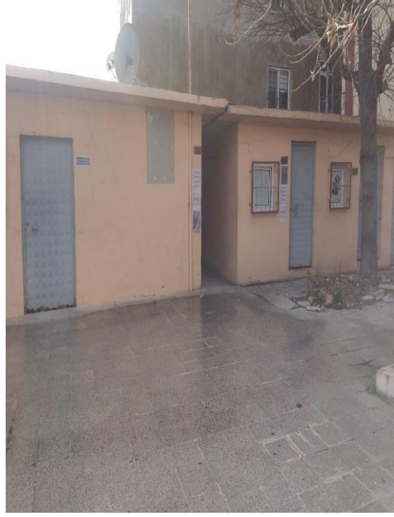
Şekil 3.108. Ek wc binası (Şar, 2020).
