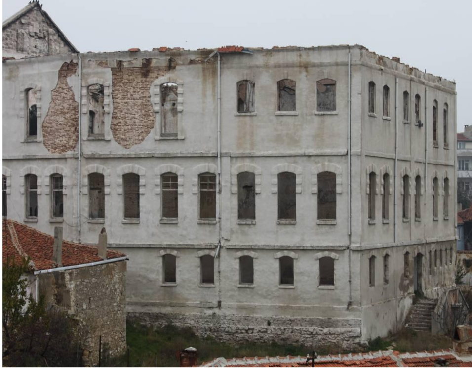
Şekil 2.44. Vali Faik Üstün İlkokulu yangın sonrası durumu (Demirli,2010: 84).
