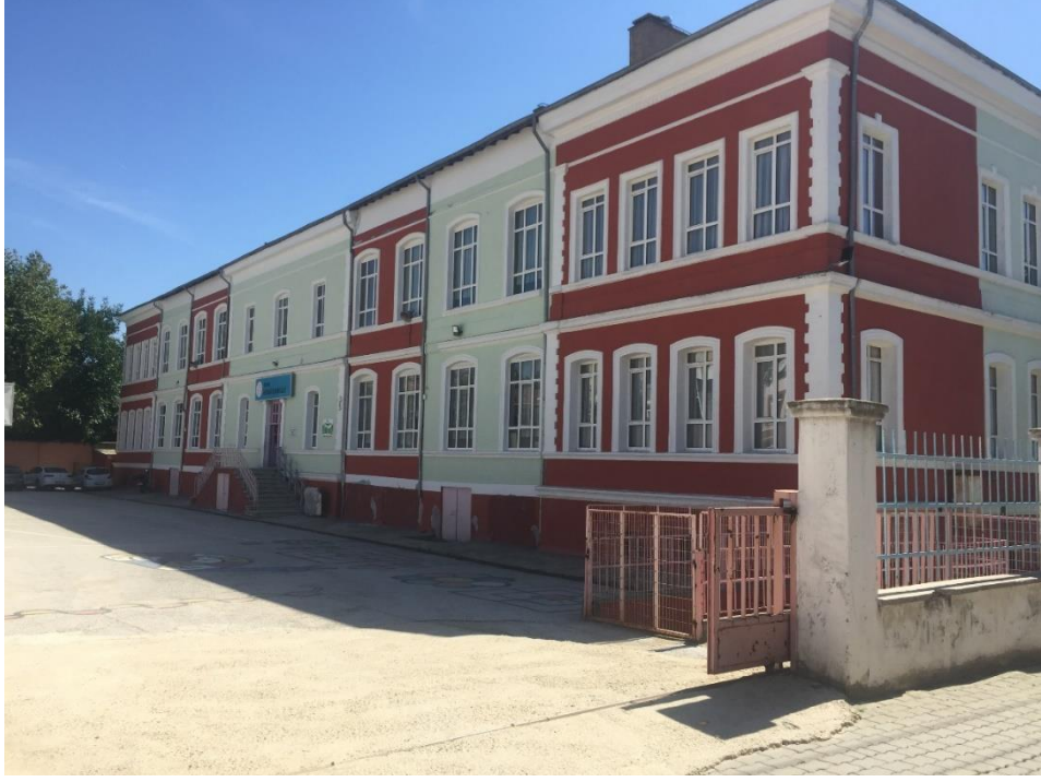
Şekil 3.53. İnönü İlkokulu kuzey cephesi (Şar, 2022).
