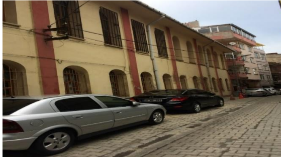
Şekil 3.121. Batı cephesi (Şar, 2020).
