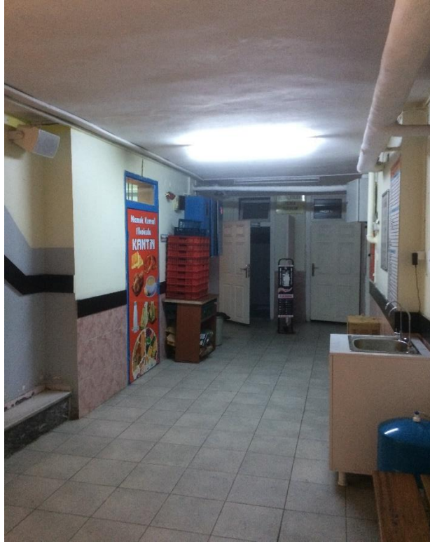
Şekil 3.168. Bodrum kat koridoru wc ve kantin (Şar, 2021).
