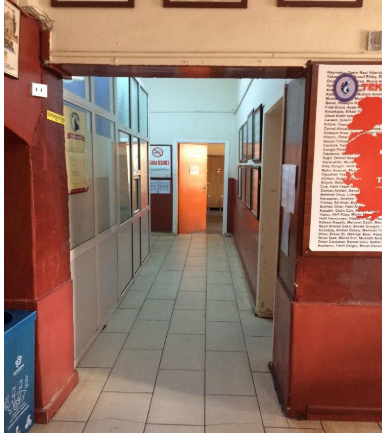
Şekil 3.100. Zemin kat kuzey kısmı (Şar, 2020).
