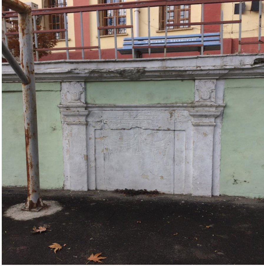
Şekil 3.117. İkinci bodrum kat duvarında bulunan çeşme (Şar, 2020).
