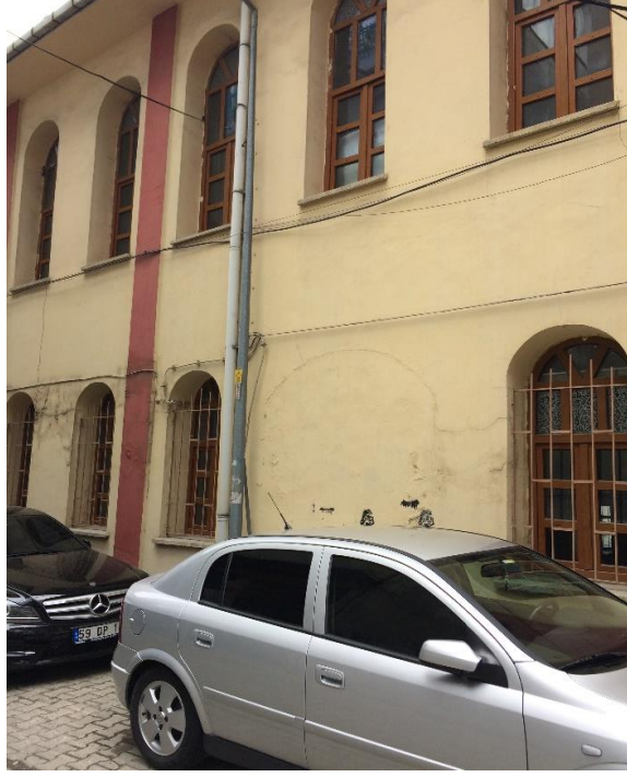
Şekil 3.122. Batı cephesinde kapatılan giriş (Şar, 2020).
