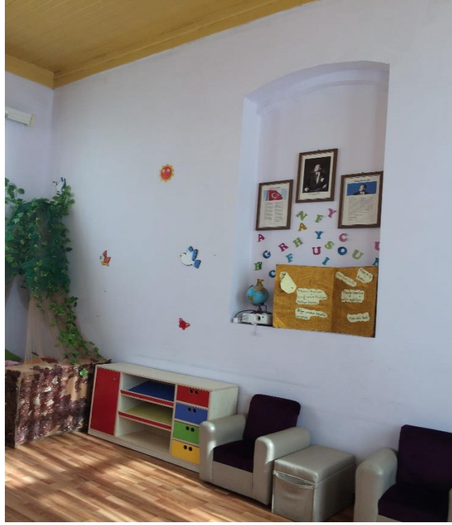
Şekil 3.137. Doğu kanadında kapatılan pencere (Şar, 2020).
