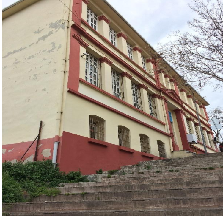
Şekil 3.172. Güneydoğu cephesi (Şar, 2020).
