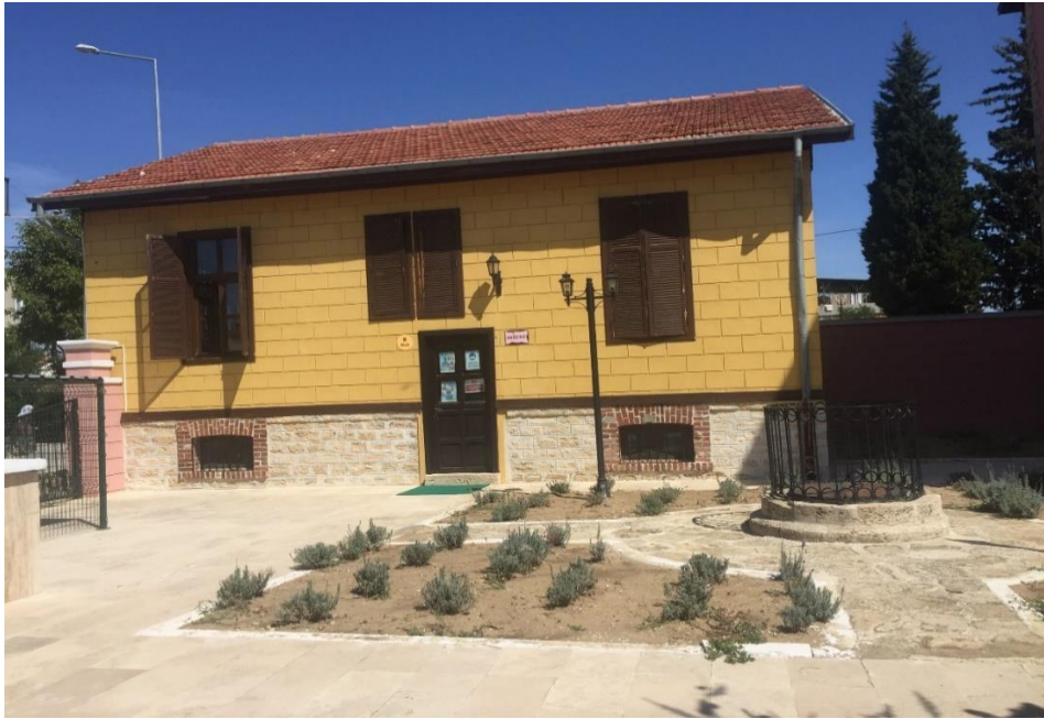
Şekil 3.69. Özgün haliyle lojman olarak kullanılan bina (B Blok) Anasınıfı binası (Şar, 2022).
