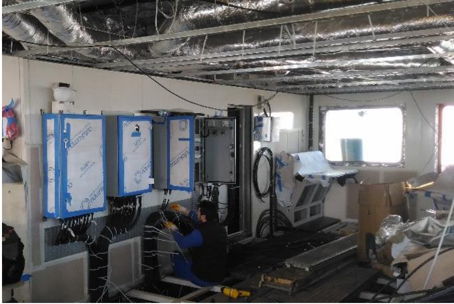
Şekil 3.20. Örnek elektrik ve aydınlatma çalışması [13].
