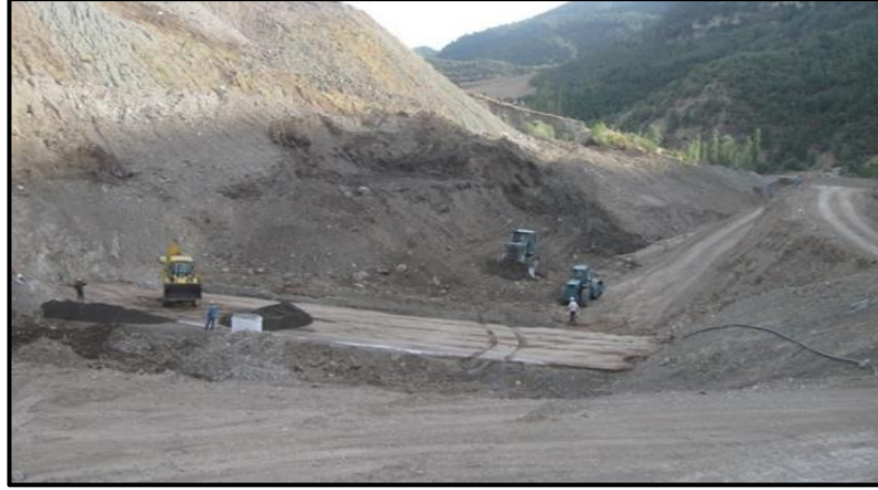
Şekil 4.6. Çorum İskilip Yeraltı Barajı yapım aşaması [2].
