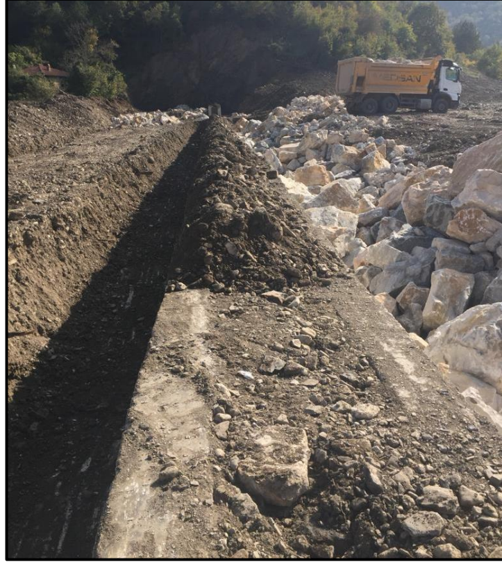
Şekil 7.13. Başlık betonları yapım işleri.
