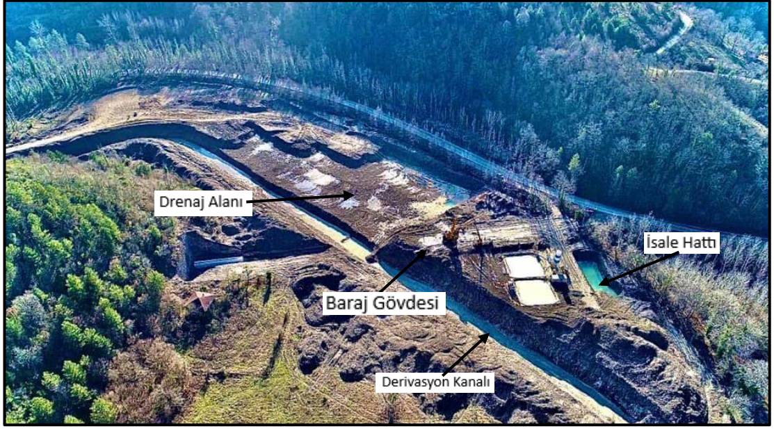
Şekil 5.3. Bahçecik Yeraltı Barajı inşaat aşaması [33].
