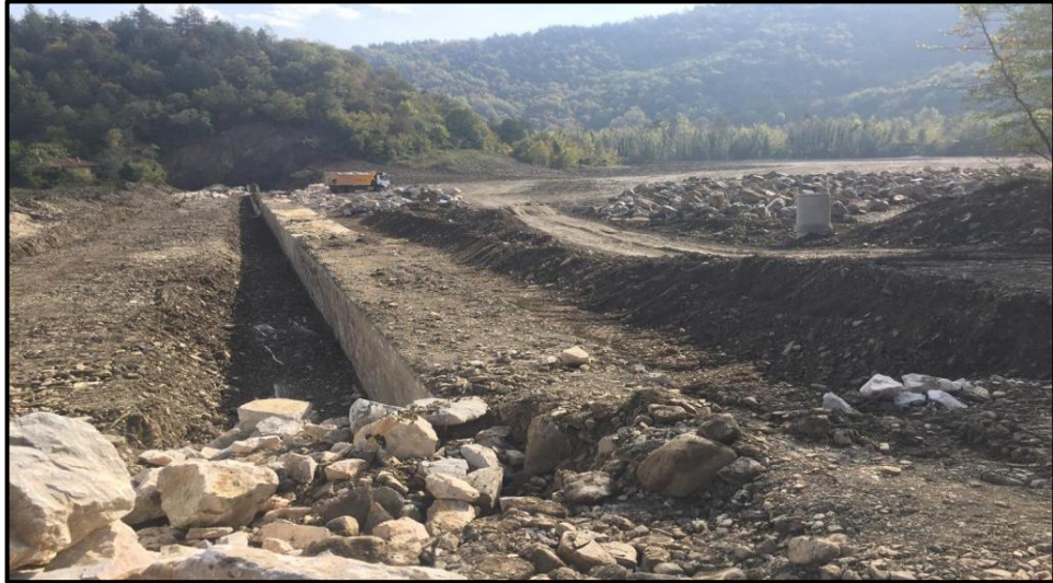
Şekil 5.10. Bahçecik Yeraltı Barajı’nın Slurry Trench gövdenin başlık betonu.
