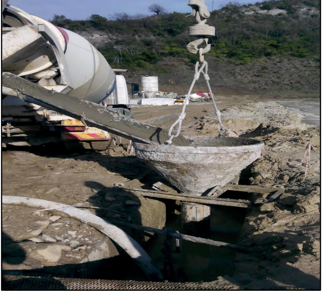
Şekil 5.13. Tremie ile döküm yapıma işlemi [33].
