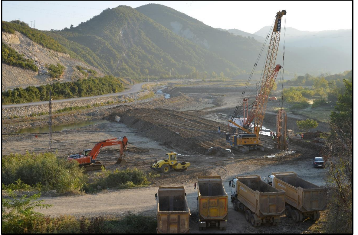
Şekil 5.12. Slurry-Trench gövde yapım çalışması [33].
