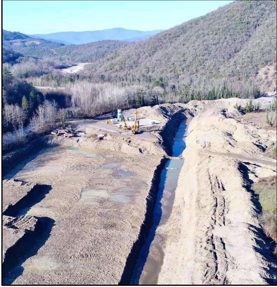
Şekil 3.4. Bartın Bahçecik Yeraltı Barajının gövdesi, derivasyon kanalı ve drenaj boruları kazı alanı [29].
