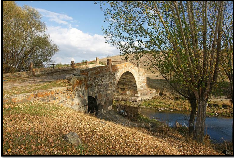
Fotoğraf 40: Çoğullu Köyü Kemer Köprüsünden Bir Görünüm
