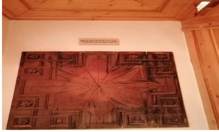
Şekil 19. Narlıdere Kültür Evinde yer alan Mezar odası bölümünün restore edilmeden önce ev halindeyken yapımında kullanılan tahtadan orijinal tavan parçası
