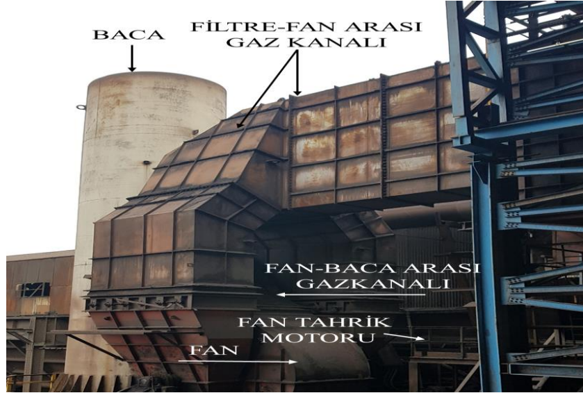
Şekil 13 400.000 m 3 /h kapasiteli online filtre gaz kanalları, fan, motor ve baca görseli.
