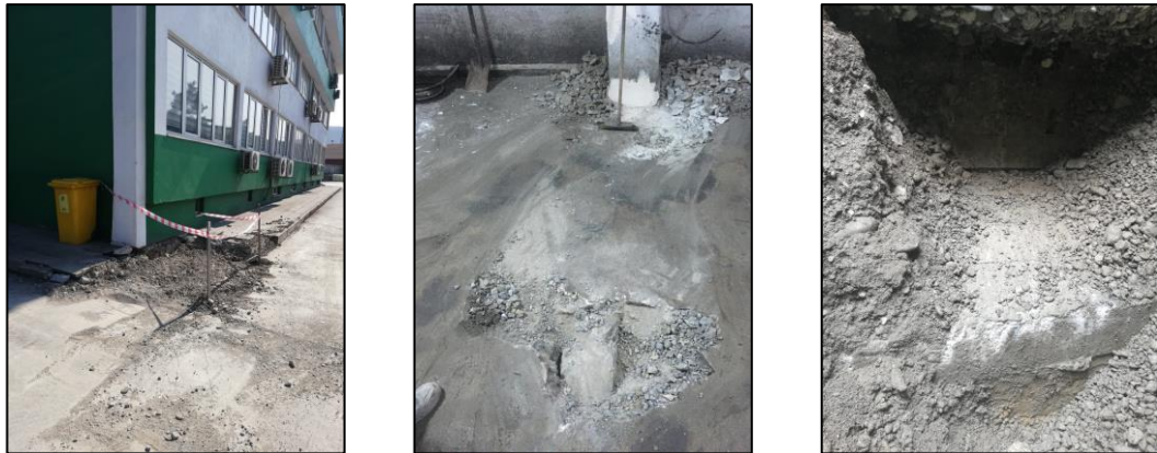
Şekil 5.6. Temel muayene çukur işlemi görselleri.
