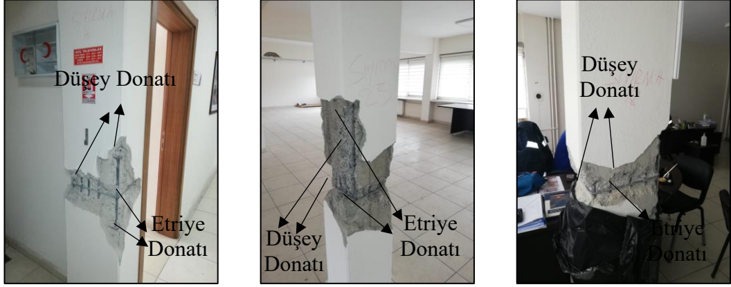
Şekil 5.34. Sıyırma işlemi görselleri.
