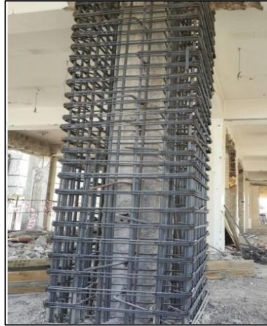
Şekil 4.2. Kesit büyütme uygulaması [63].
