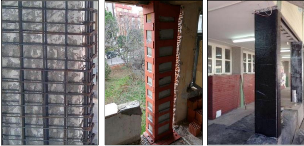
Şekil 4.1. Kolon sargı uygulama görseli (a) Betonarme sargı uygulaması, (b) Çelik sargı uygulaması, (c) LP sargı uygulaması [63].
