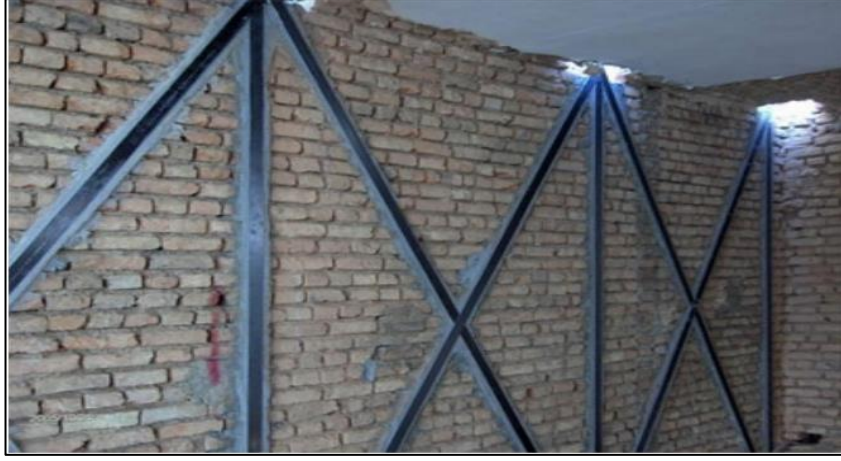
Şekil 4.4. Bölme duvar güçlendirme uygulaması [60].
