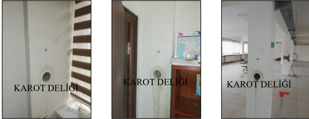
Şekil 5.33. Alınan karot numune görselleri.
