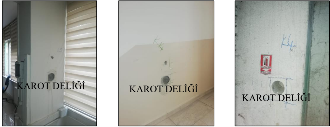
Şekil 5.4. Alınan karot numune görselleri.
