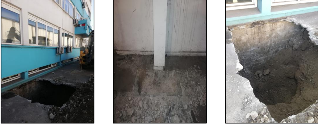
Şekil 5.35. Temel muayene çukur işlemi görselleri.
