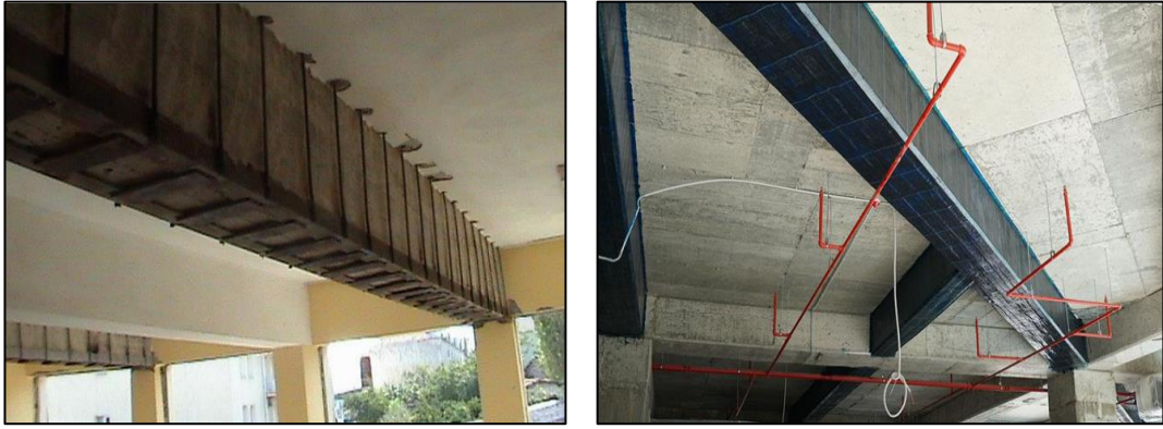
Şekil 4.3. Kiriş sargı uygulama görseli (a) Dıştan etriye ekleme uygulaması, (b) LP sargı uygulaması [63].
