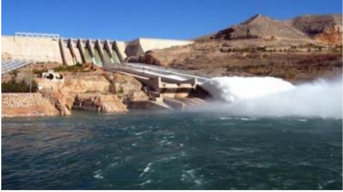
Şekil 1.16. Hidroelektrik enerji santrali [27].
