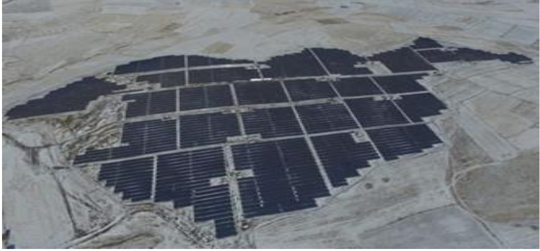
Şekil 3.24. Derinkuyu Güneş Enerjisi Santrali [48].
