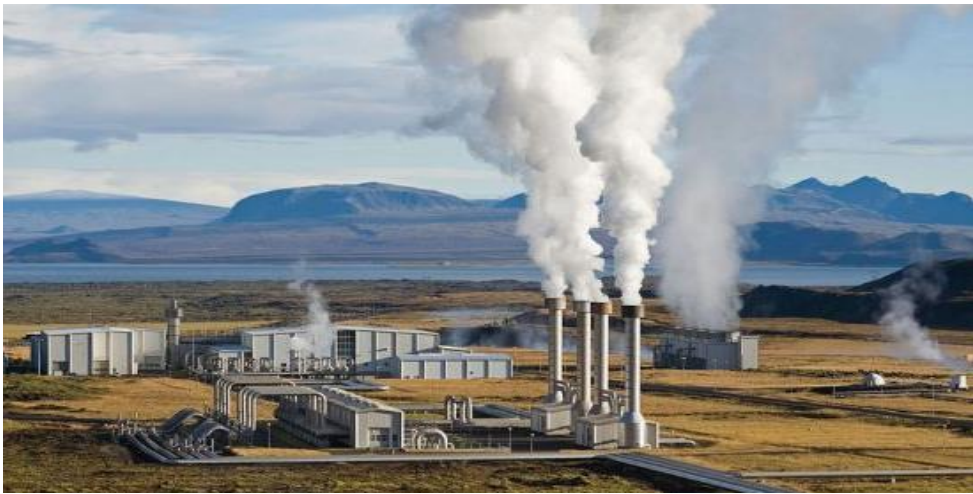
Şekil 1.12. Jeotermal enerji santrali [21].
