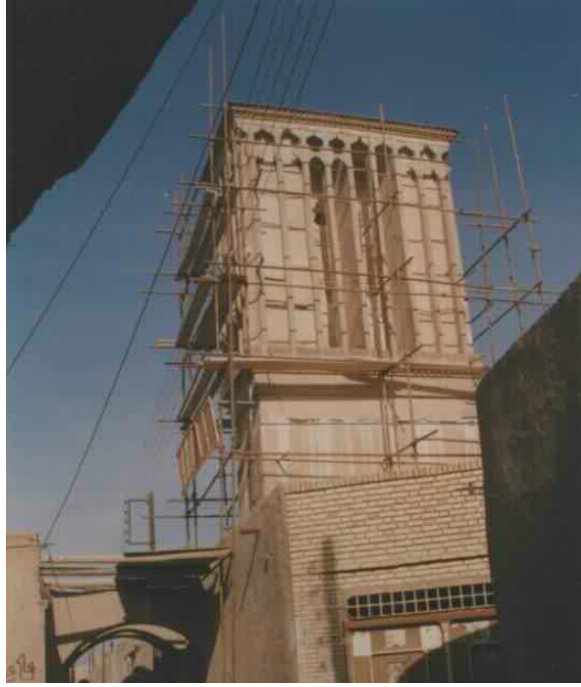
Şekil 3. 7. Yazd'de tamir edilen tipik bir Rüzgar bacası [50].
