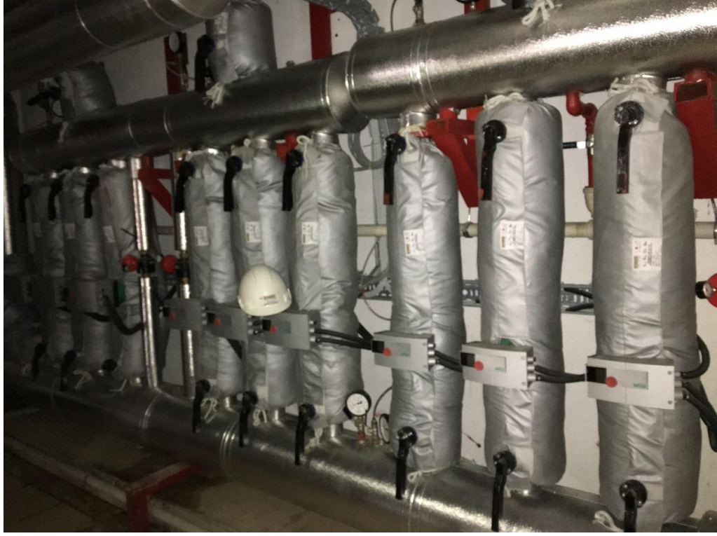
Şekil 3.21. Ek Yerleri Vana Ceket Kullanımı
