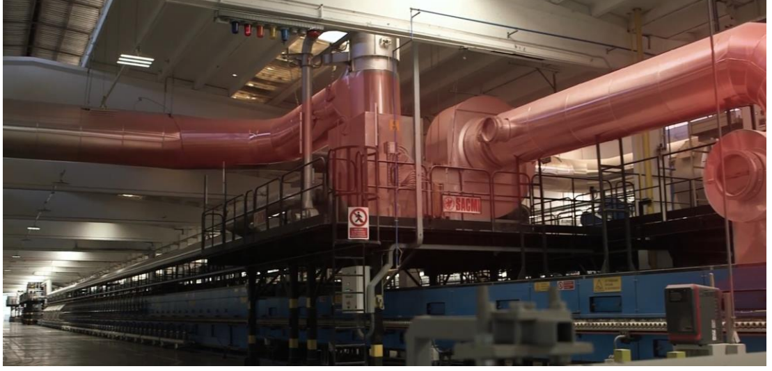
Şekil 3.1. Seramik Fırın Atık Hava Sirkülasyonu
