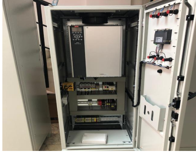
Şekil 3.31. Pano içi sürücü ve diğer yerleşimler
