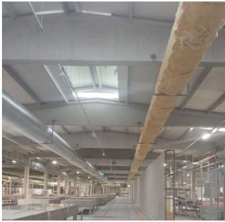
Şekil 3.20. Boru Hattı İzolasyon ve Kaplamalar
