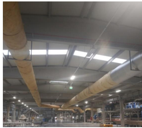
Şekil 3.20. Boru Hattı İzolasyon ve Kaplamalar
