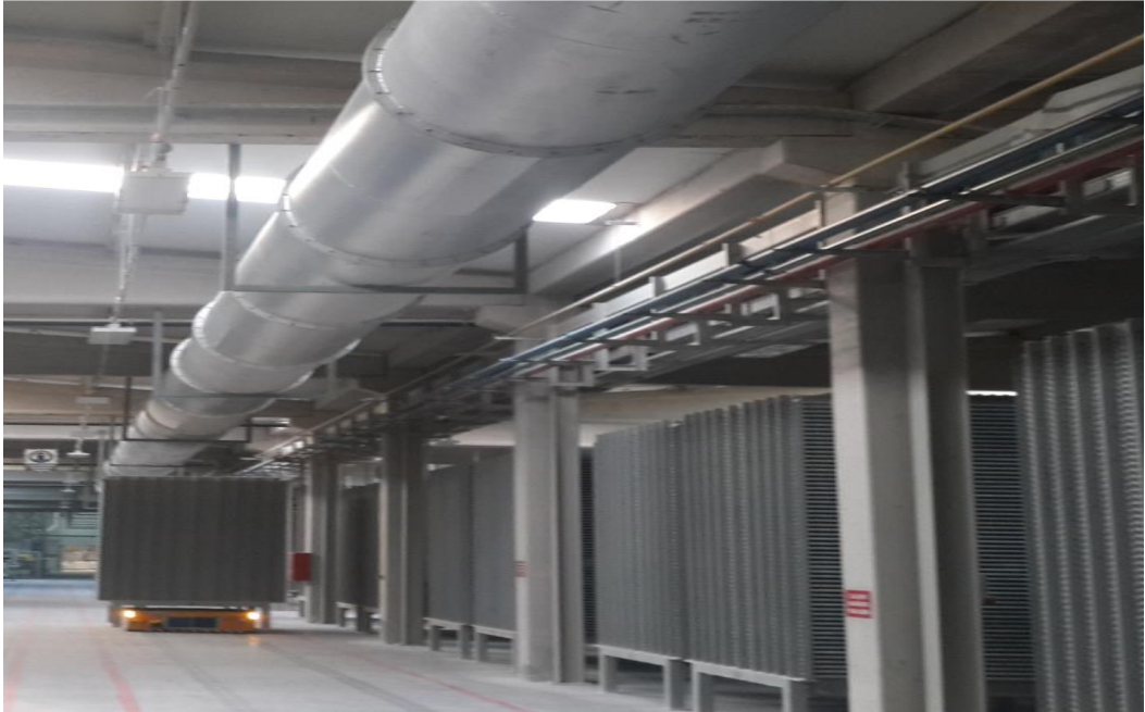
Şekil 3.12. Boru Hattı Montajı
