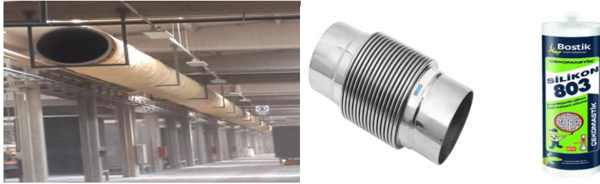
Şekil 3.34. Konsollama, Kompensatör ve Yanmaz Silikon
