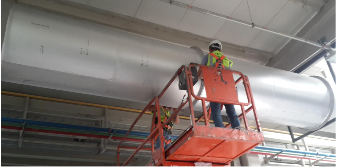
Şekil 3.13. Boru Hattı Montajı Flanş Bağlantıları
