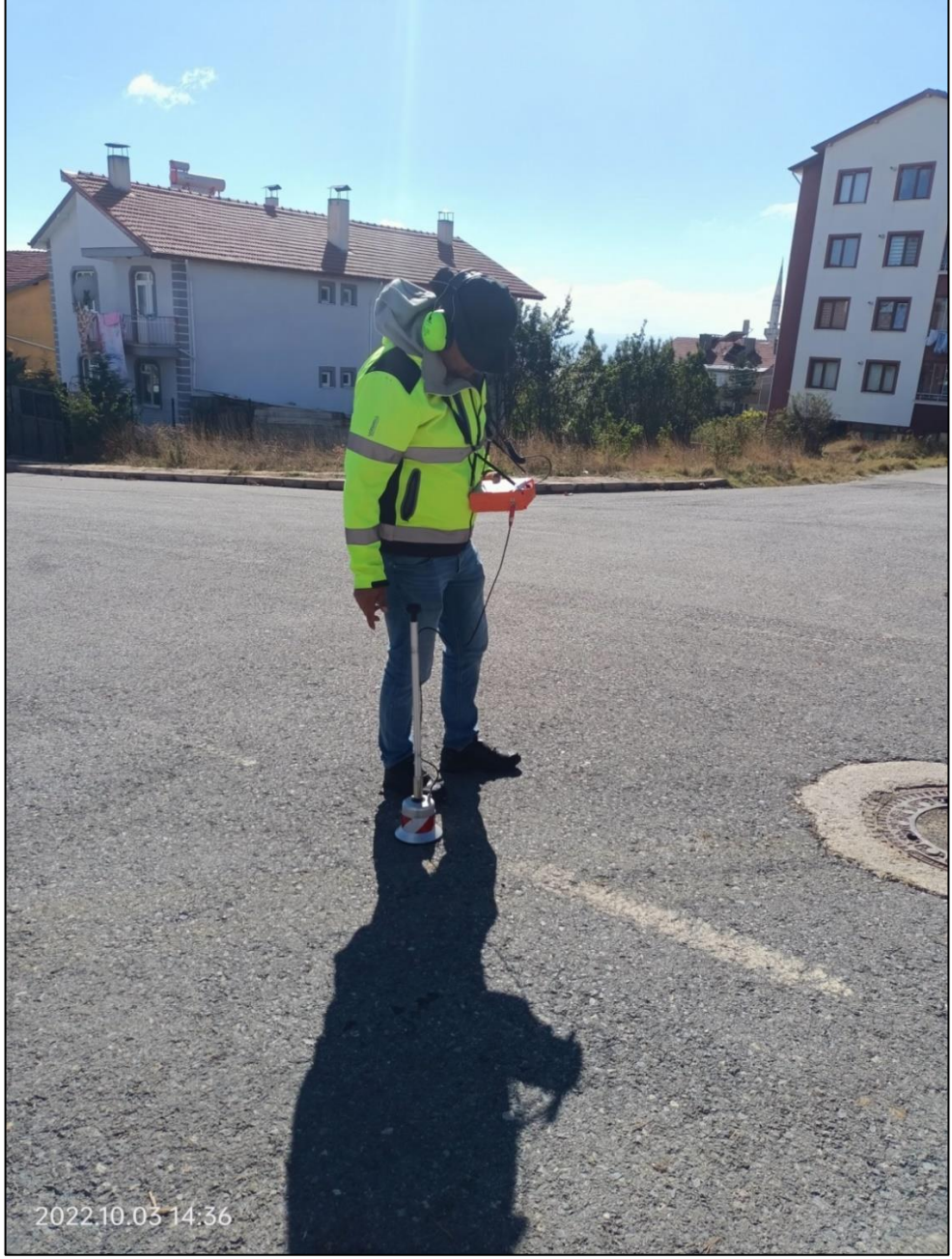
Şekil 2.31. İçmesuyu sızıntı-kaçağı arama çalışmaları
