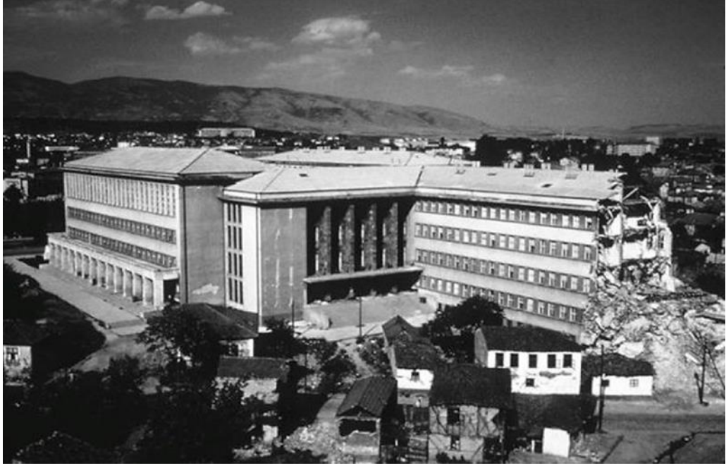
Şekil 3.16. 1949'dan kalma UKIM kampüsünün depremden kaynaklanan yıkımı gösteren eski bir fotoğraf [74].
