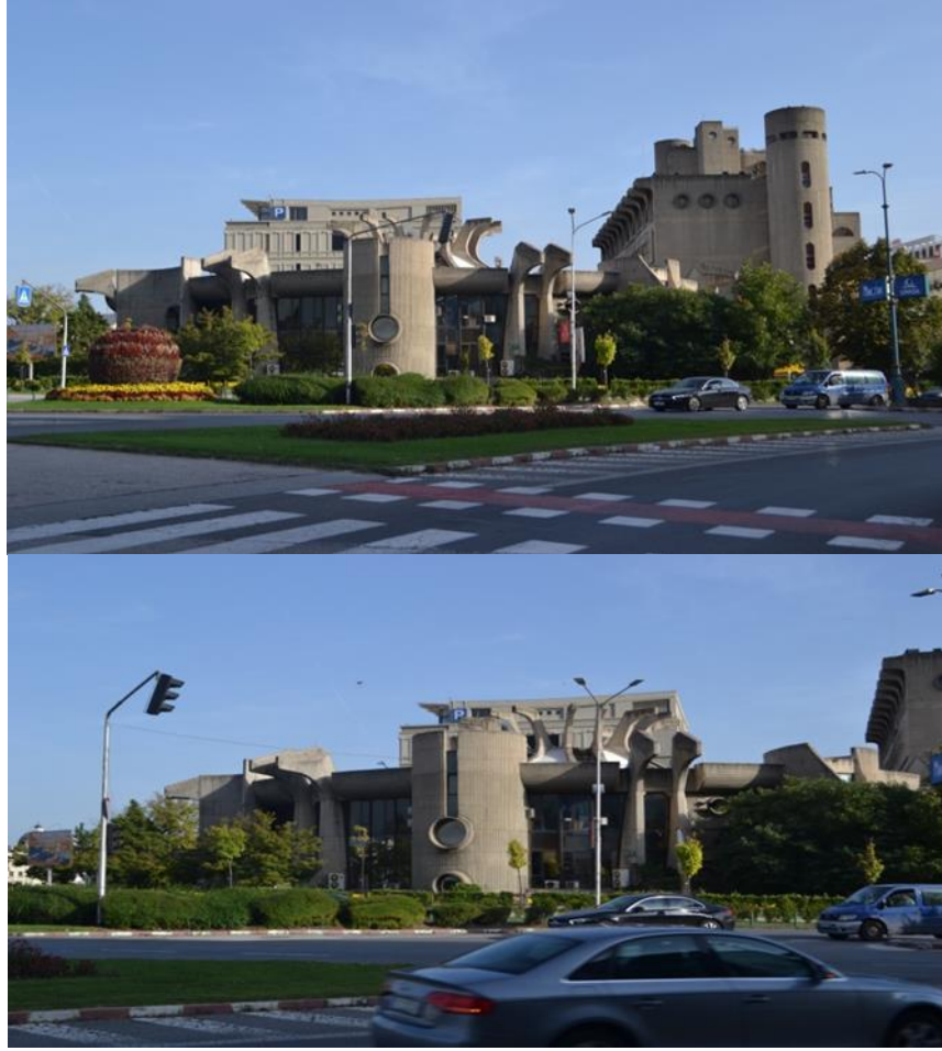
Şekil 3.15. Postane ve Telekomünikasyon Merkezi [72].
