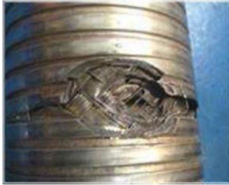
Şekil 0.8. Korozyona uğramış malzeme [63].
