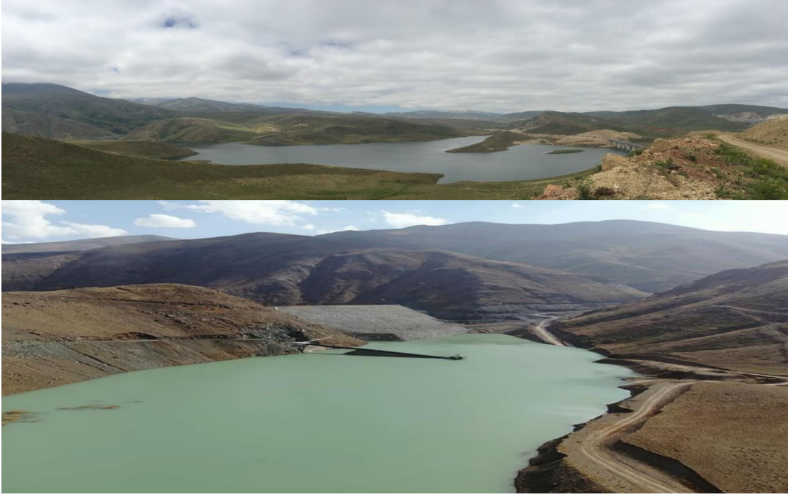
Fotoğraf 77. Turnaayırı Barajı
