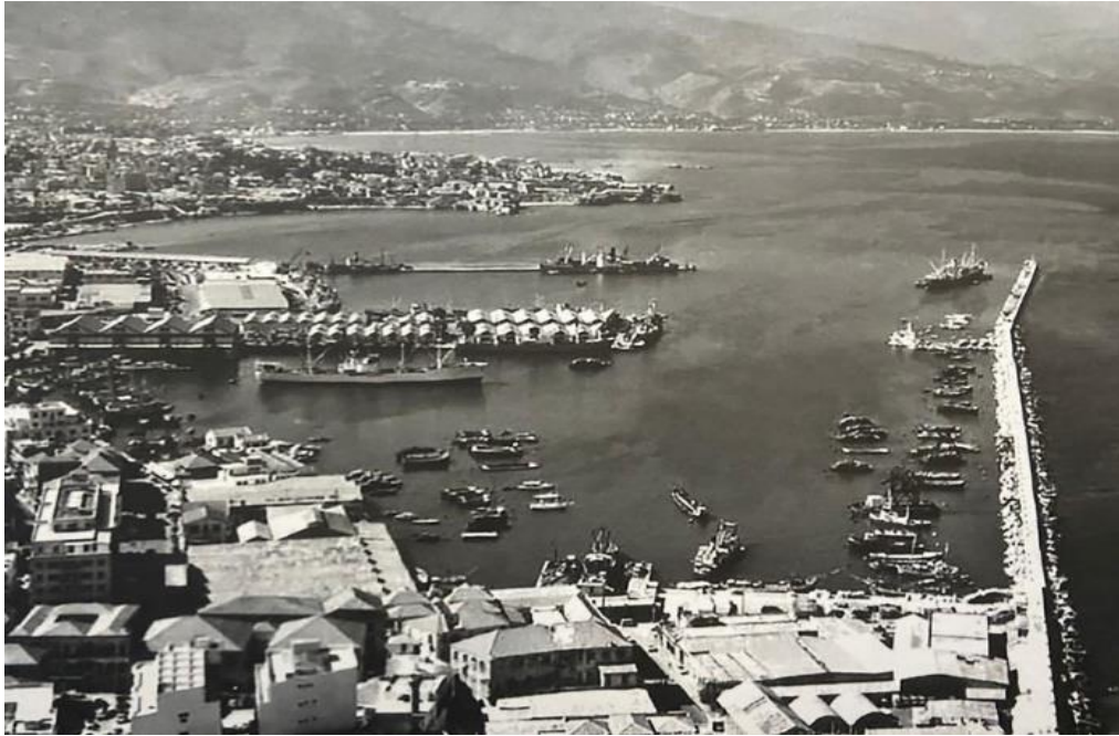
Şekil 2. 28. 1975'te dördüncü havzanın inşaatı [16]
