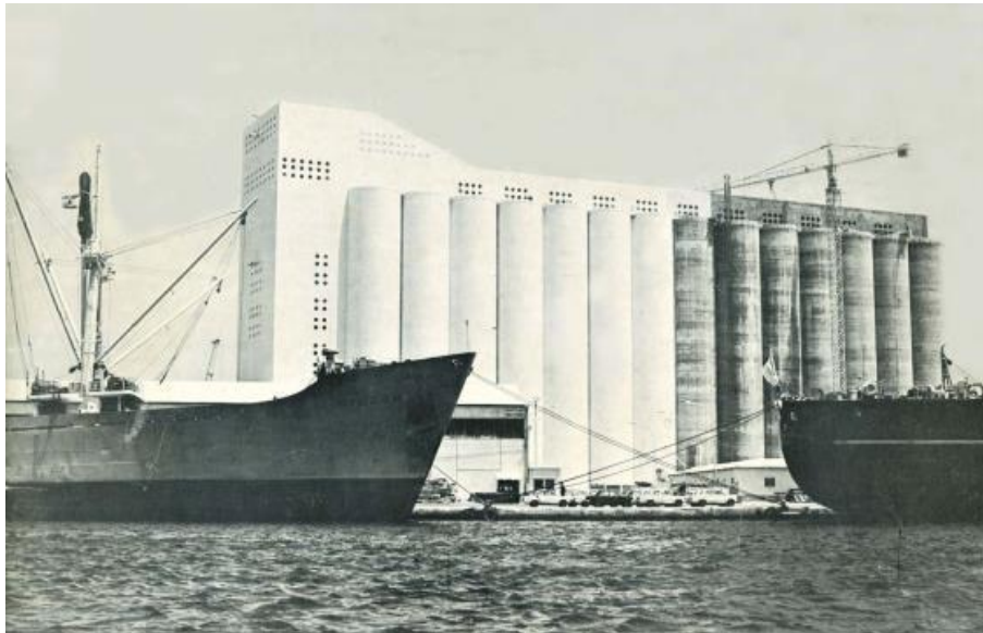
Şekil 3. 14. Faz-I: tahıl siloları tamamlandı ve Faz-II: silolar tamamlanmak üzere. [46]
