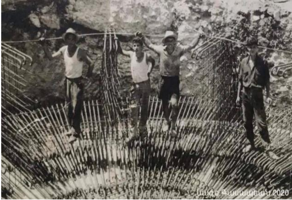
Şekil 2. 27. Yapım aşamasındaki Beyrut Siloları (1968-1970) – Sarkis Joulfayan [17]
