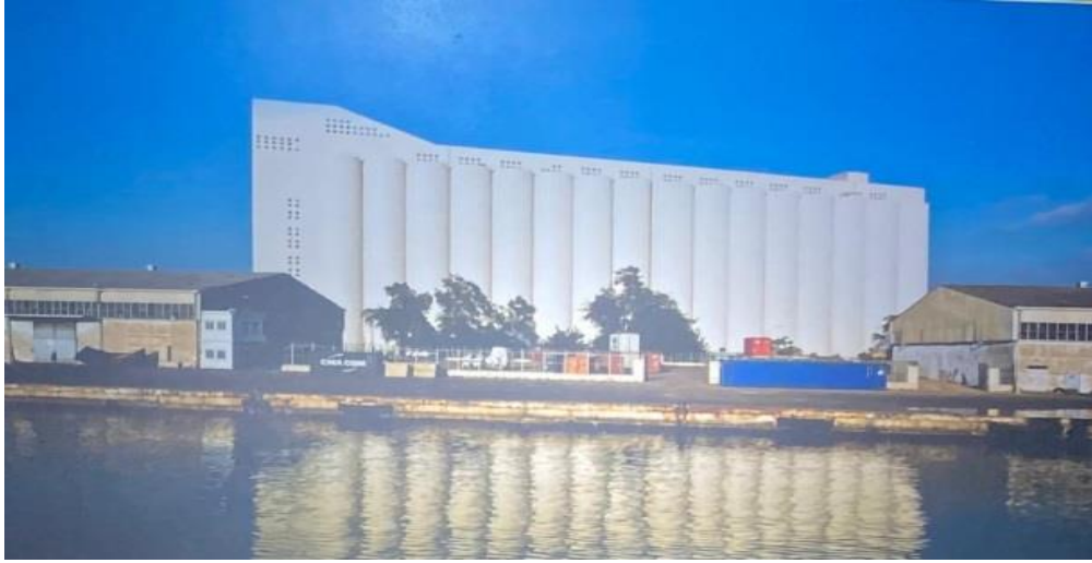
Şekil 2. 29. POB Silosu, 2.500 ton/hücre kapasiteli 48 büyük hücre ve 500 ton/hücre kapasiteli 50 küçük hücreden oluşmaktadır.[19]
