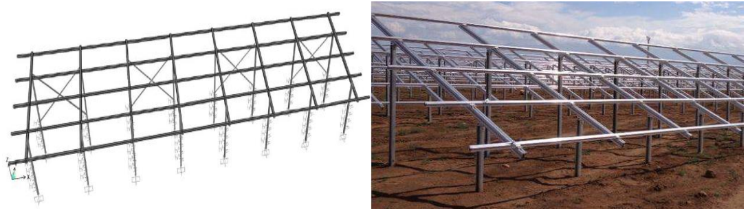
Şekil 2.4. Arazi tipi konstrüksiyon sistemi ve uygulaması
