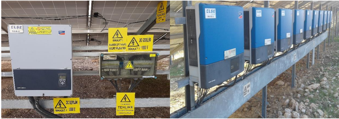
Şekil 2.9. Dizi tipi inverterler
