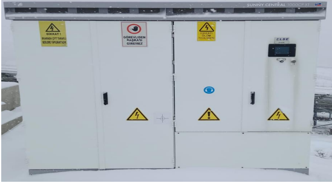
Şekil 2.10. Merkezi inverterler
