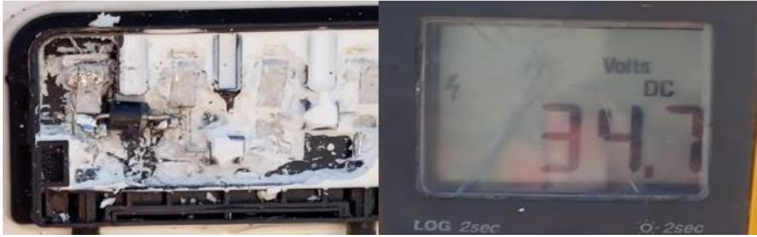
Şekil 4.13. Güneş paneli onarım sonrası bağlantı kutusu ve voltaj durumu
