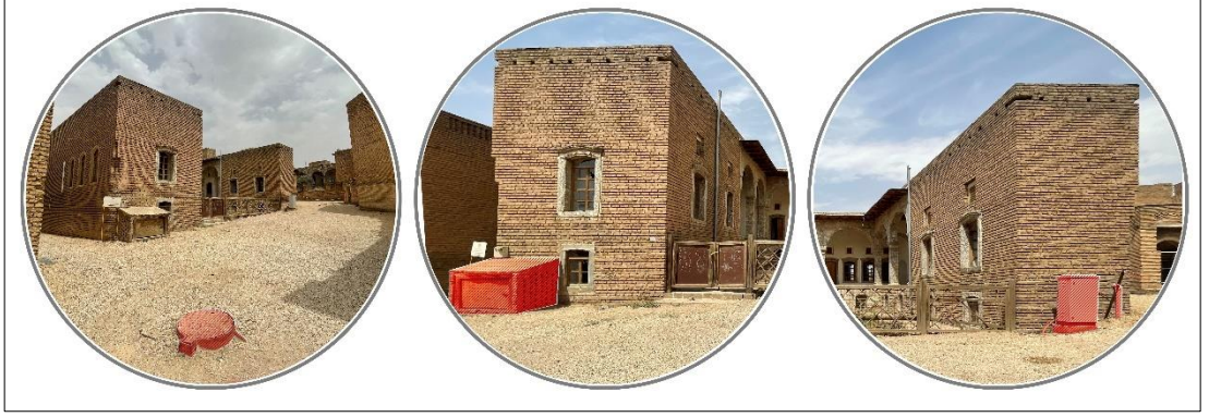
Şekil 4. 15. Fethah Çelebi Binası Altyapısı
