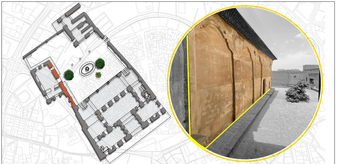
Şekil 4. 44. Raşid Ağa Divanı Hanının avlu duvarının sıva ile kaplanması
