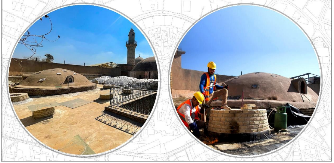
Şekil 4. 60. Binada izogam (bitümlü kaplamalar) ile çatı su yalıtımı
