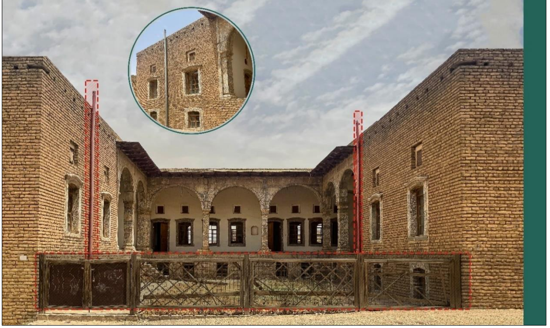
Şekil 4. 19. Avlu Ahşap Çiti ve Su Boruları
