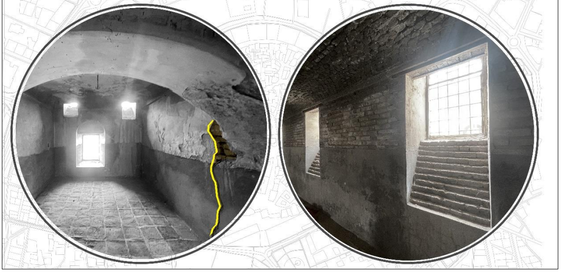
Şekil 4. 46. Raşid Ağa Divan Hanında Yarı Bodrum Tuğla Duvarlar
