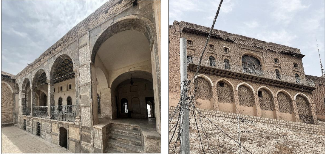
Şekil 4. 34. Raşid Ağa Divanı Hanının Avlu İçinden Görünümü ve Raşid Ağa Divanı Hanının Pazardan ve Şehir Parkı Çeşmelerinden Görünümü
