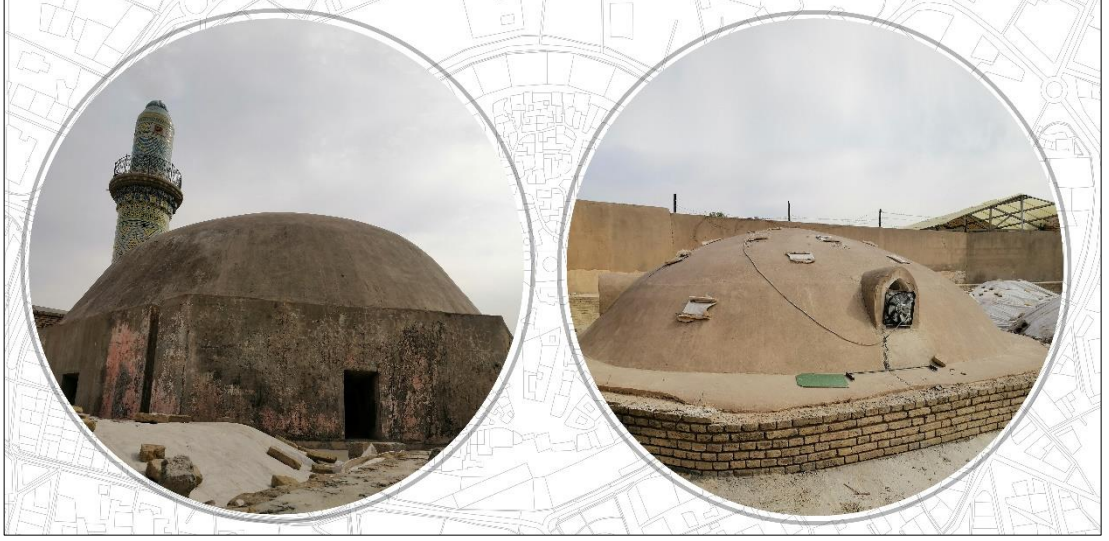
Şekil 4. 61. Tonoz ve Mezarların Beton Katmanlarla Kaplanması
