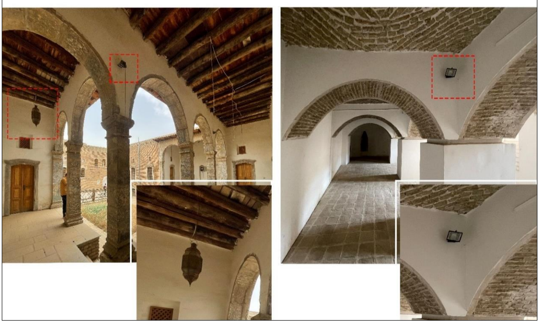
Şekil 4. 24. Fettah Çelebi Binası'nda yapay aydınlatma
