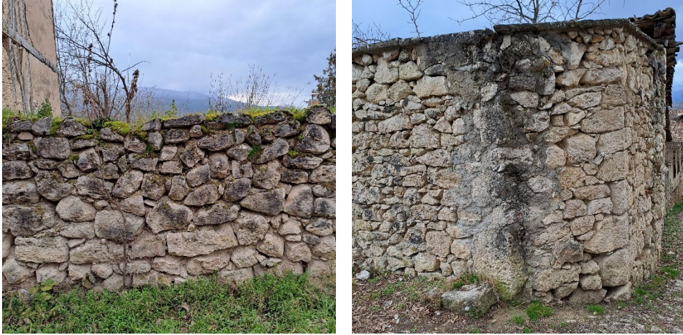
Şekil 5.14. Dış ortamda kullanılan Yazıköy taşı üzerinde siyah renkli kabuklaşma.
