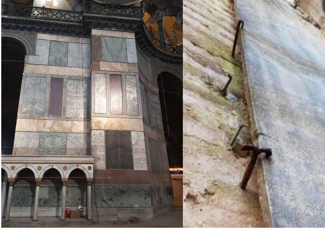
Şekil 2.14. Ayasofya, İç Mekân Kuzey Duvar Taş Kaplamalarından Görünüm, Farklı Özellikteki Metal Donatılar Yardımı İle Sabitlenmiş Dış Cephe Kaplama Taşı (Buzlu ve Binan, 2022).
