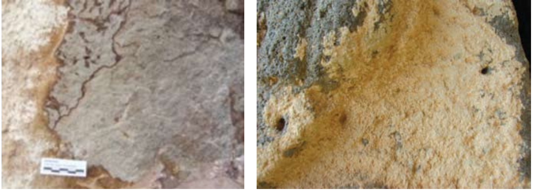
Şekil 5.4. Taş yüzeylerde çeşitli kalınlıklarda tabaka ayrışmaları (Ali & Murat, 2012).
