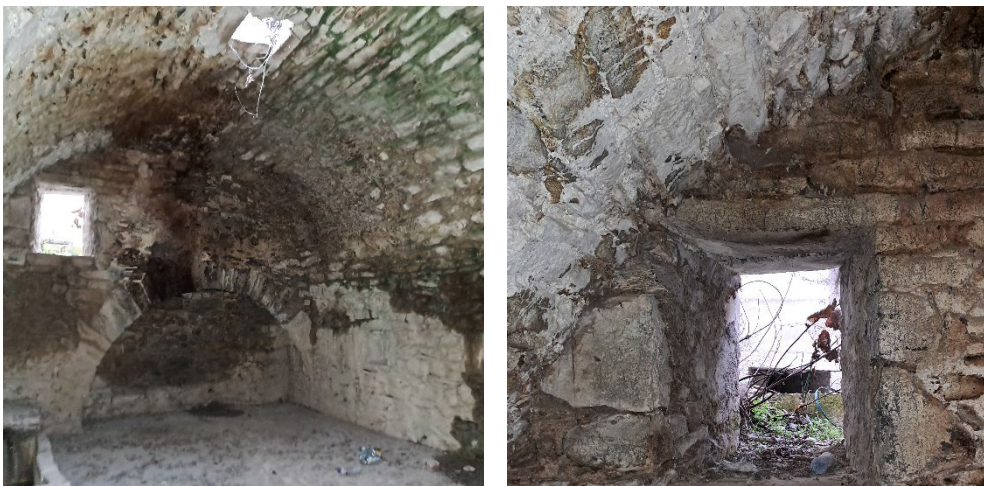
Şekil 5.15. Metruk durumdaki Yazıköy çamaşırhanesinin içinde görülen beyaz kabuklaşmalar.
