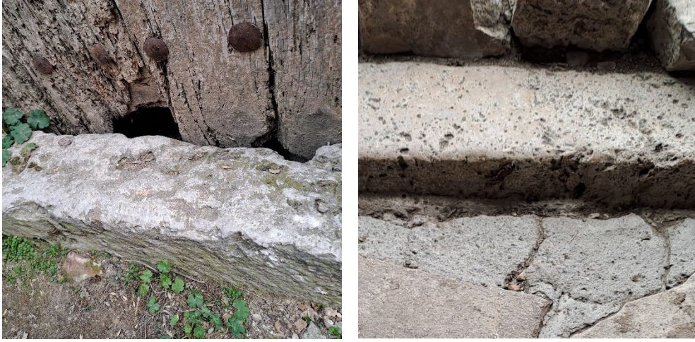
Şekil 5.11. Mekanik etki altında aşınmaya uğramış Yazıköy taşları.
