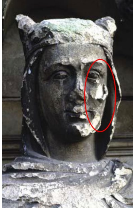
Şekil 2.29. Doğal taş malzemede kabuklanma örneği (Zakar & Eyüpgiller, 2015).
