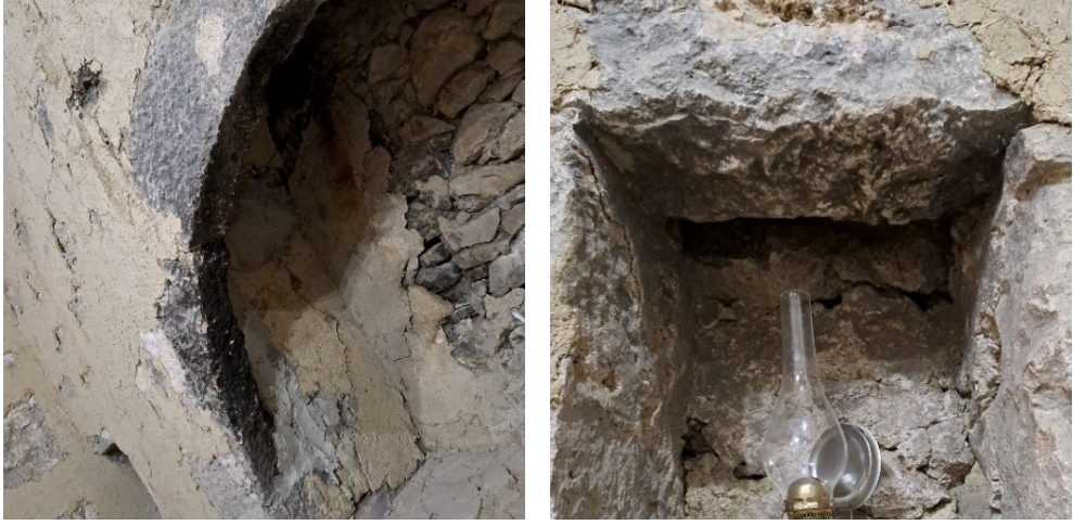
Şekil 5.20. Yazıköy taşı üzerinde is birikmesi.
