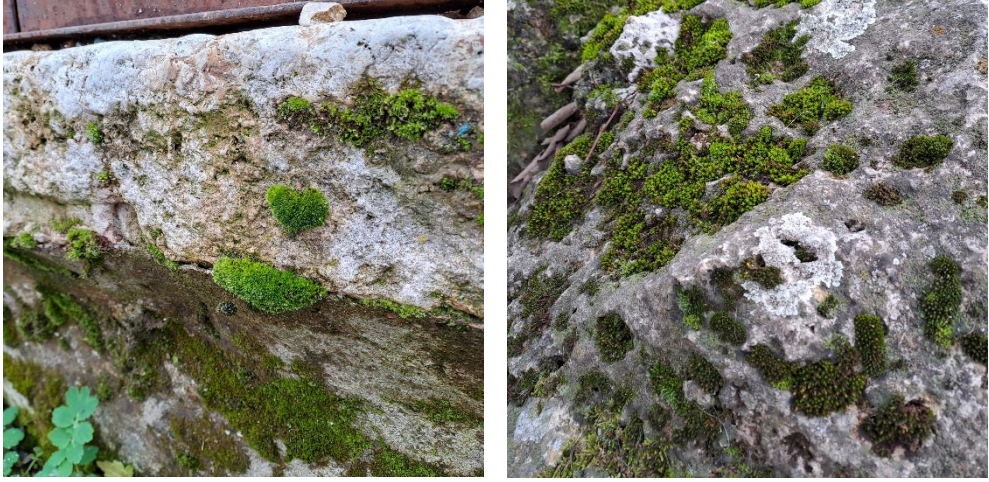
Şekil 5.23. Yazıköy taşı üzerinde görülen biyolojik yerleşim
