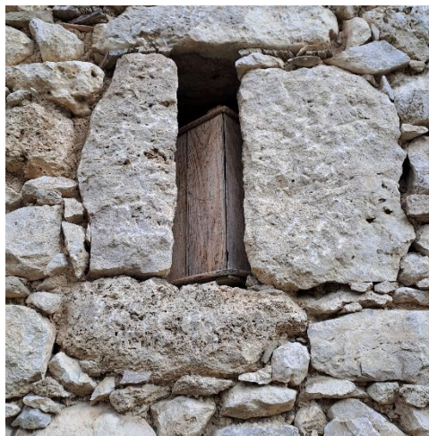
Şekil 5.8. Denizlik olarak kullanılan Yazıköy taşında görülen erozyon.
