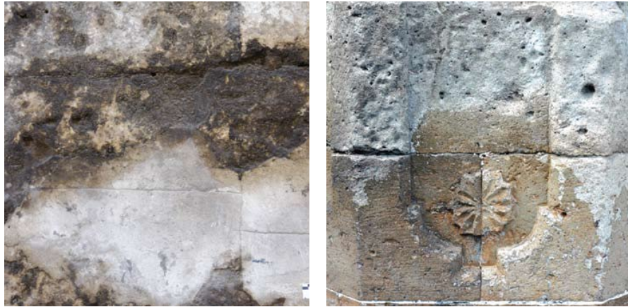
Şekil 5.13. Solda Kırklareli Hızır Paşa Külliyesi Hamamı'nda siyah renkli kabuk oluşumu, sağda Bitlis İslahiye Şeref Han Medresesi duvarında beyaz renkli kabuk oluşumu (Ali & Murat, 2012).
