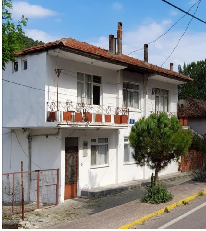
Fotoğraf 94: Yeni Yapılarda Yer Alan Balkon Örneği (Kızderbent)
