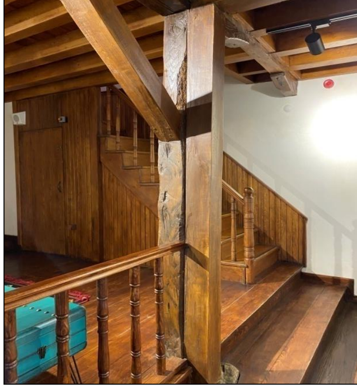
Fotoğraf 98: Eski Yapıdan Kalma Sol Direk, Restorasyon Sonucu Eklenmiş Sağ Direk
