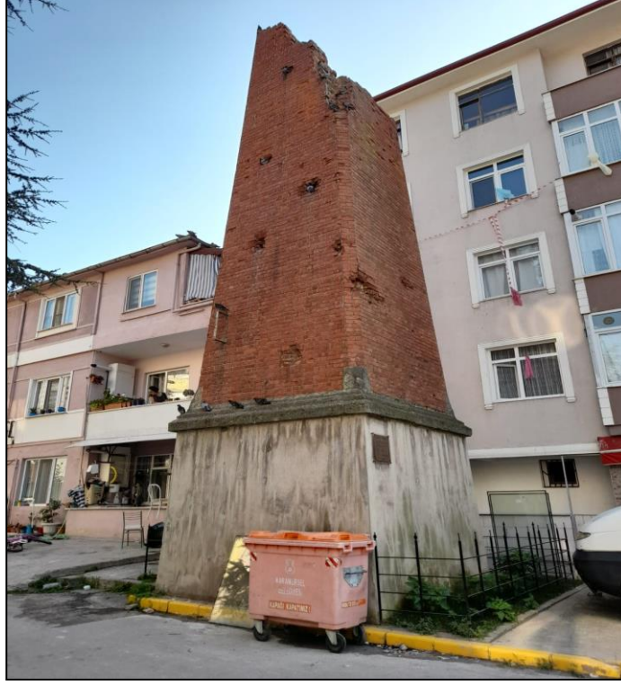
Fotoğraf 11: Karamürsel Dokuma Fabrikası Bacası (Altınkemer)
