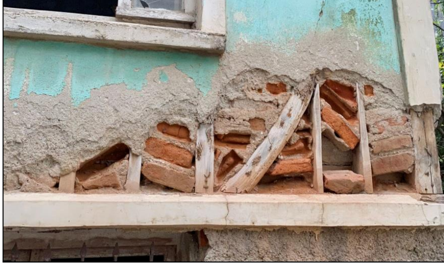
Fotoğraf 99: Restore Edilmemiş Ereğli Evlerinden Birinin Bina İskeleti Örneği
