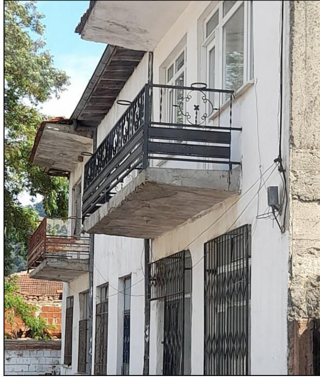
Fotoğraf 93: Yeni Yapılarda Yer Alan Balkon Örneği (Kızderbent)
