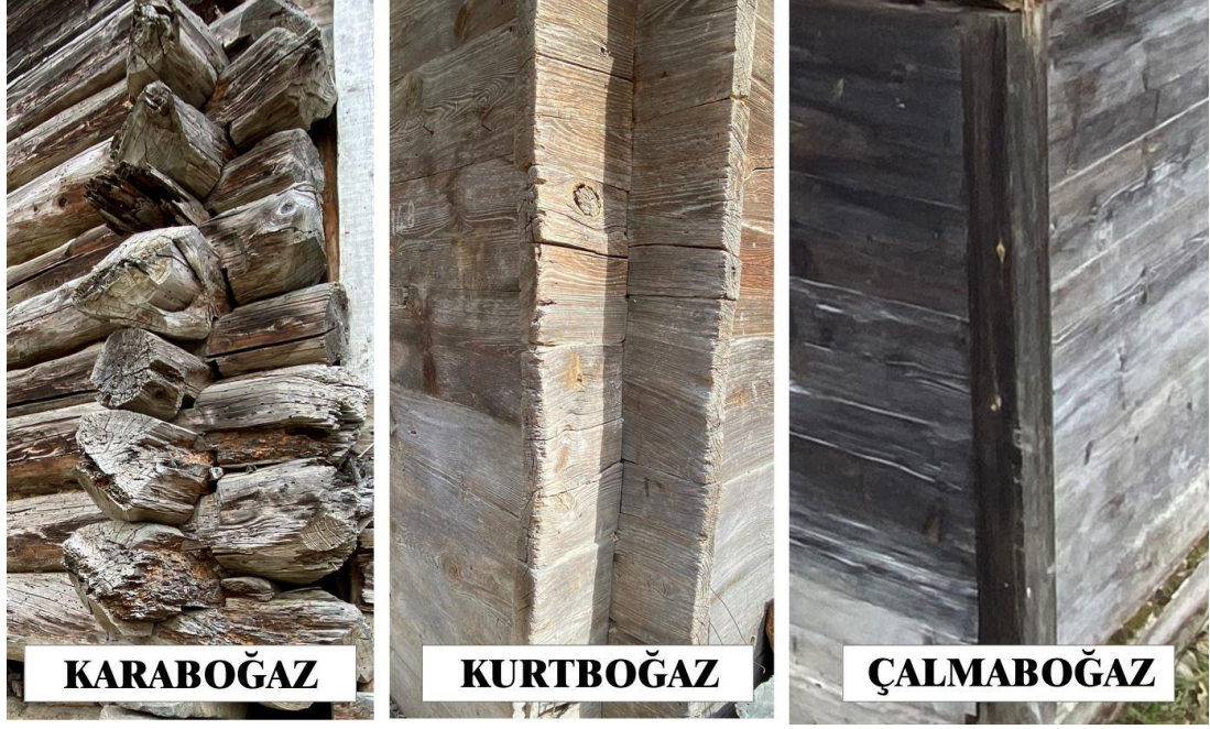
Şekil 2.34. Çantı tekniğinde kullanılan geçme detayları (Köse, 2021).
