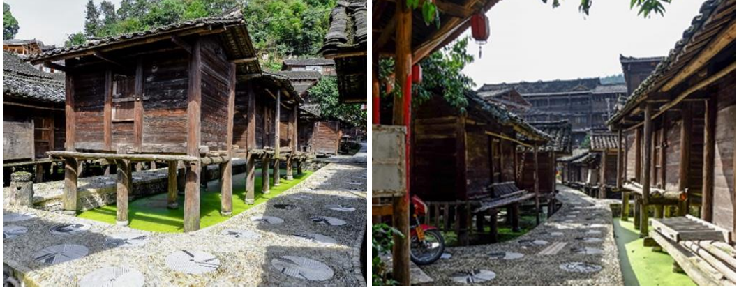
Şekil 2.11. Çin Datang Miao köyü su üzerinde inşa edilen tahıl ambarları (Url 10).
