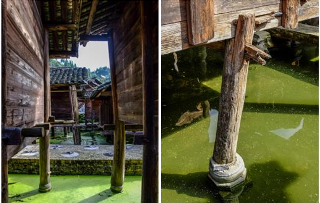
Şekil 2.12. Çin Datang Miao köyü su üzerinde inşa edilen tahıl ambarları detay (Url 10).
