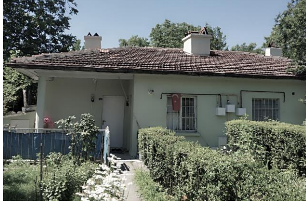
Şekil 3.5. A1 tipi işçi konutlarının giriş cephesi.
