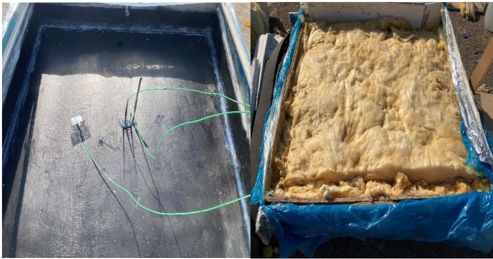
Şekil 3.3. Havuzun tabanı ve ısı yalıtım malzemesinin yerleşimi
