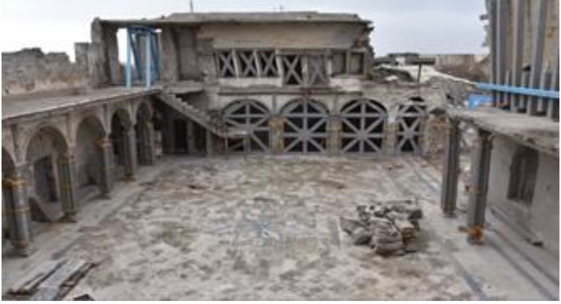
Şekil 2.45. Yıkılan Al-Tahera Kilisesi (UNESCO, 2022).
