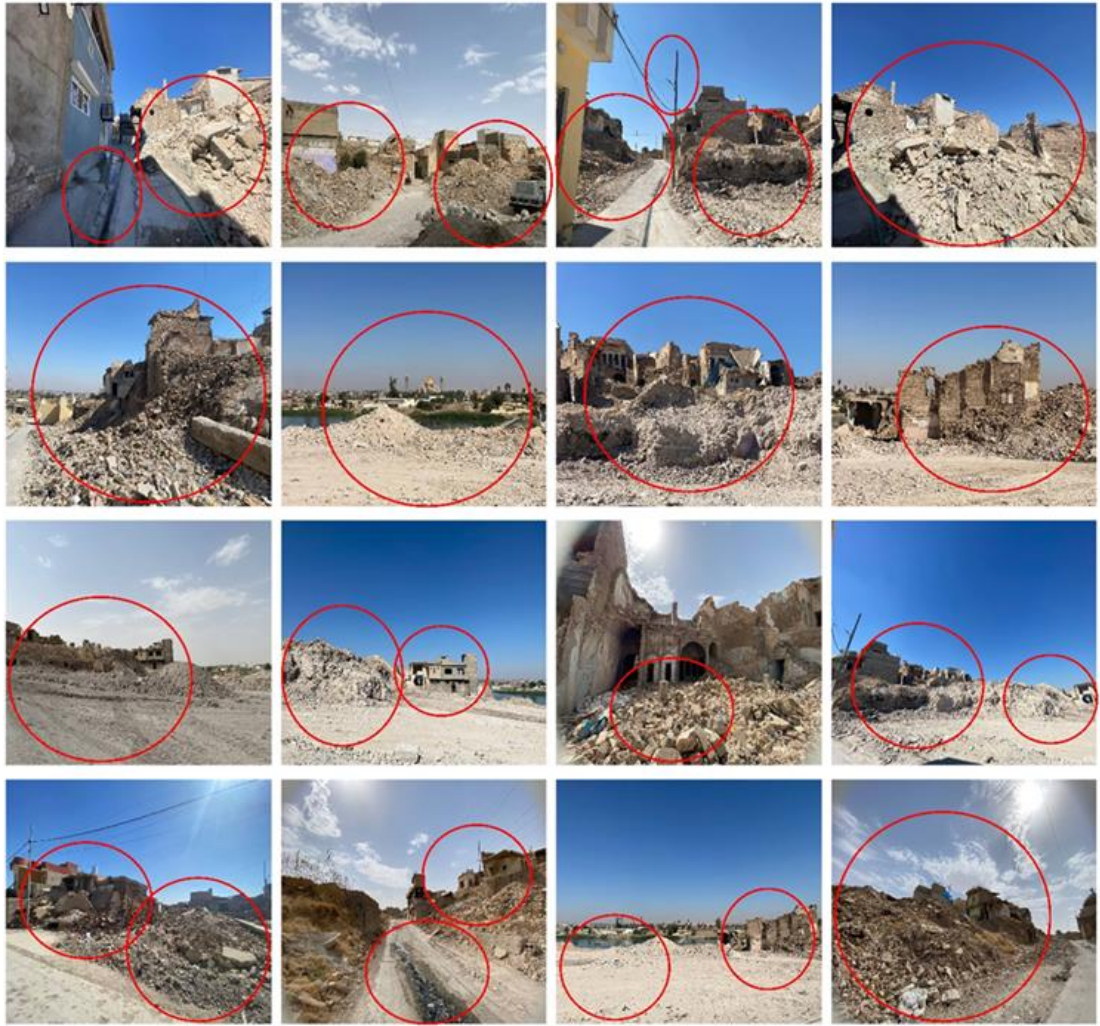
Şekil 4.32. Meydan mahallesindeki yıkılan yapılar.
