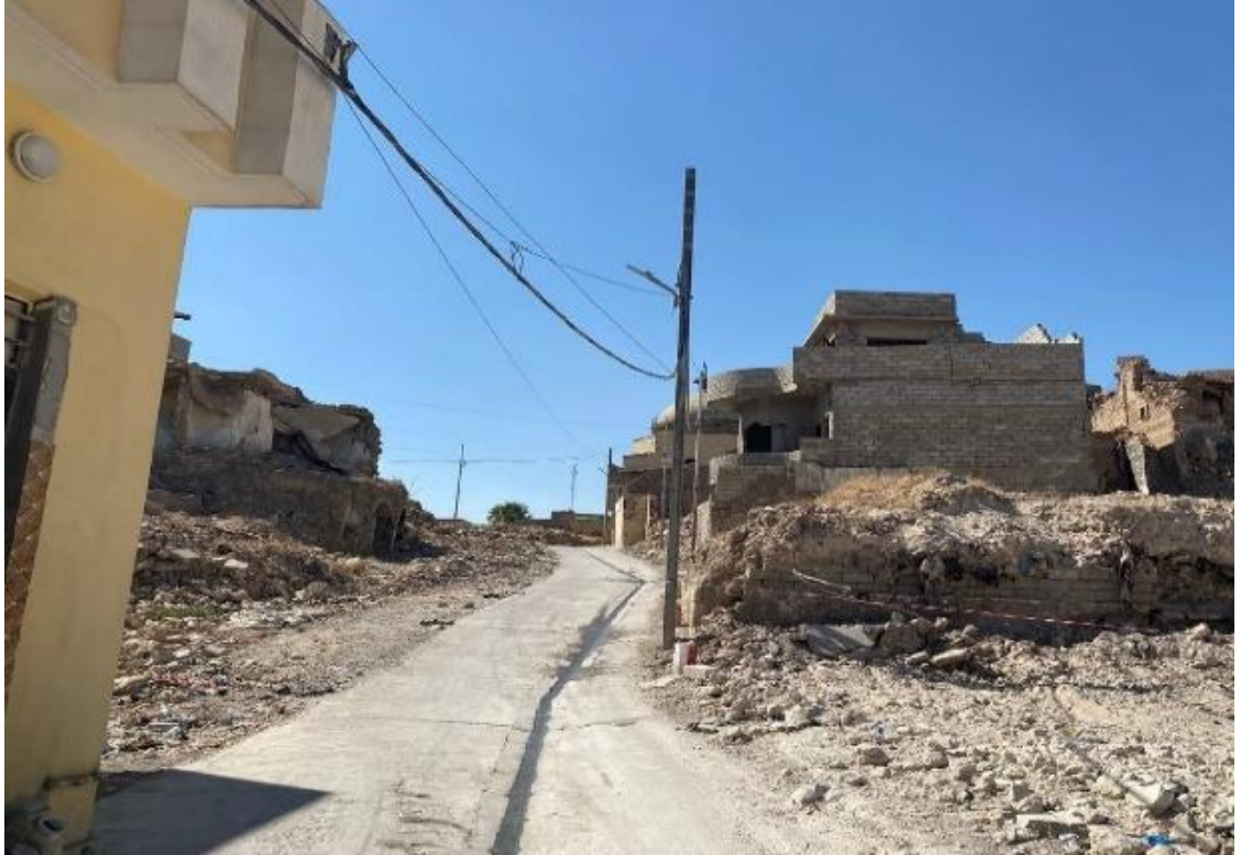
Şekil 4.50. Musul şehri altyapı problemleri.
