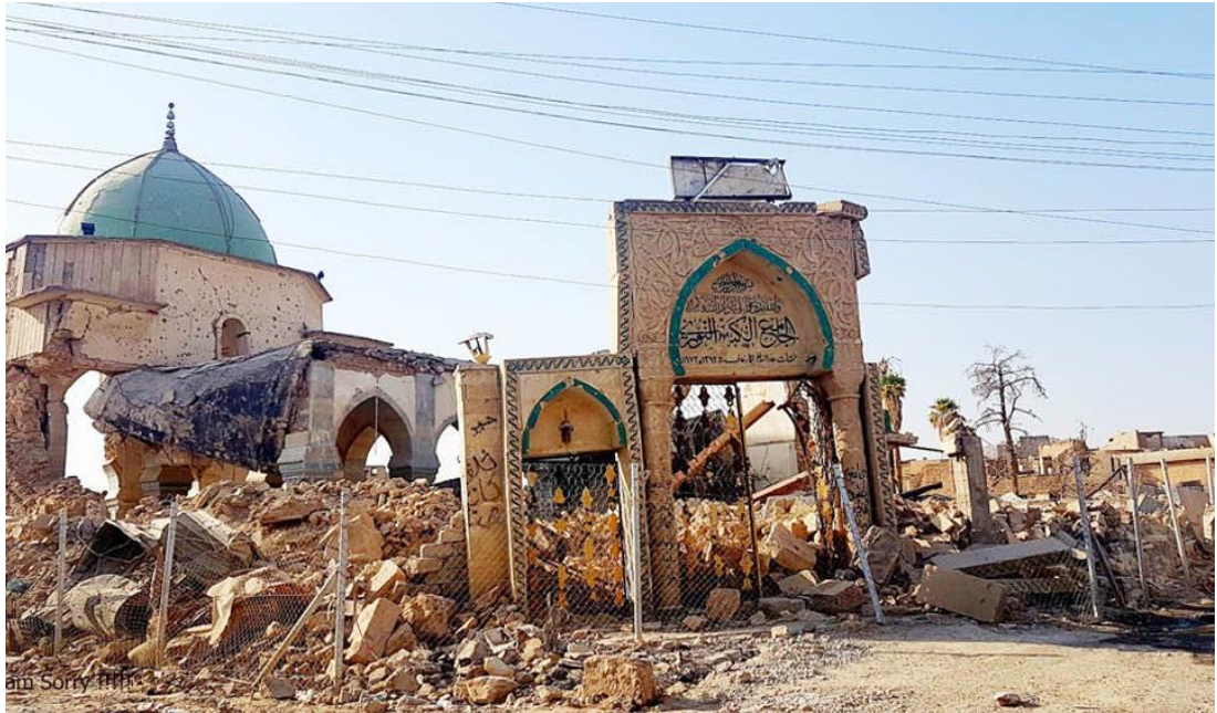
Şekil 2.41. Yıkıldıktan sonra Al-Nur Camii (UNESCO,2022).
