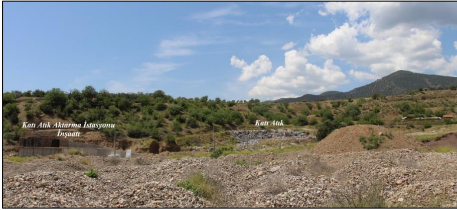
Fotoğraf 153: Sarıcakaya İlçesindeki Katı Atık Aktarma İstasyonu İnşaatı
