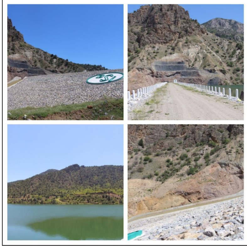
Fotoğraf 16: İnhisar İlçesinde İnşası Tamamlanan Tarpak Gölet'inden Görünümler
