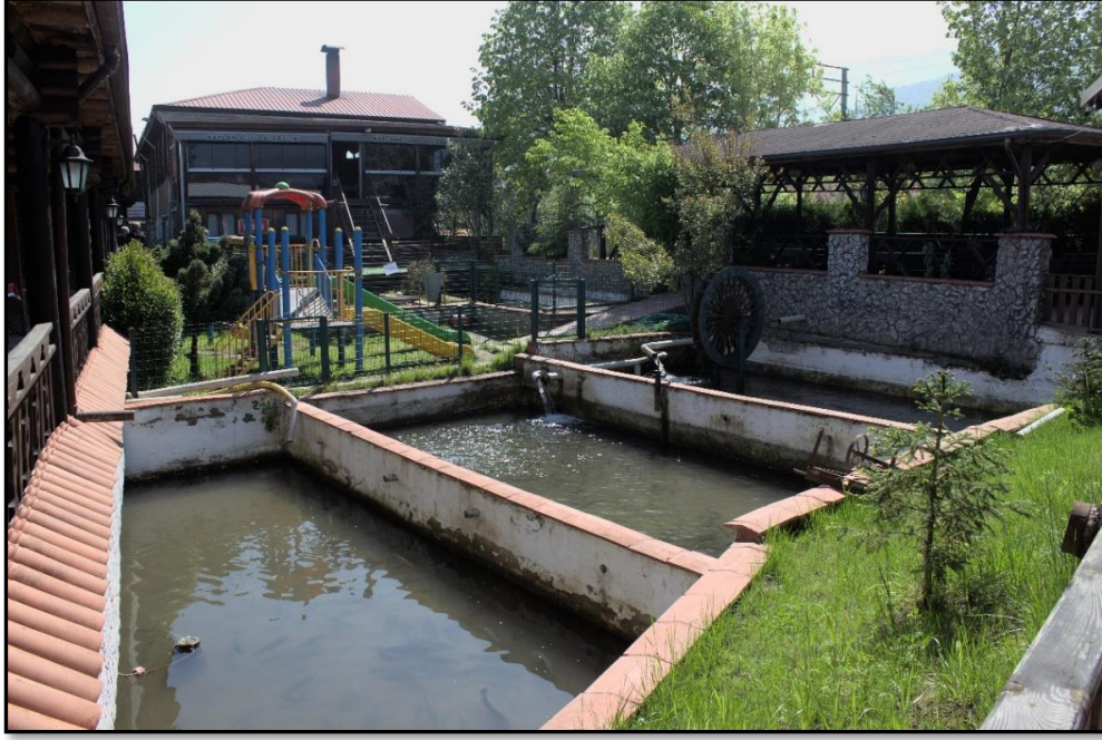
Fotoğraf 73: Düzce Kaplanoğlu Alabalık Tesisi
