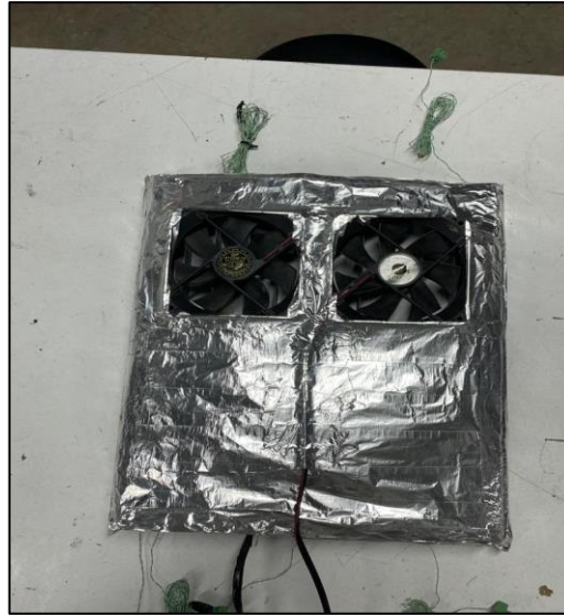
Şekil 5. 15. PV/T panel fan montajı.
