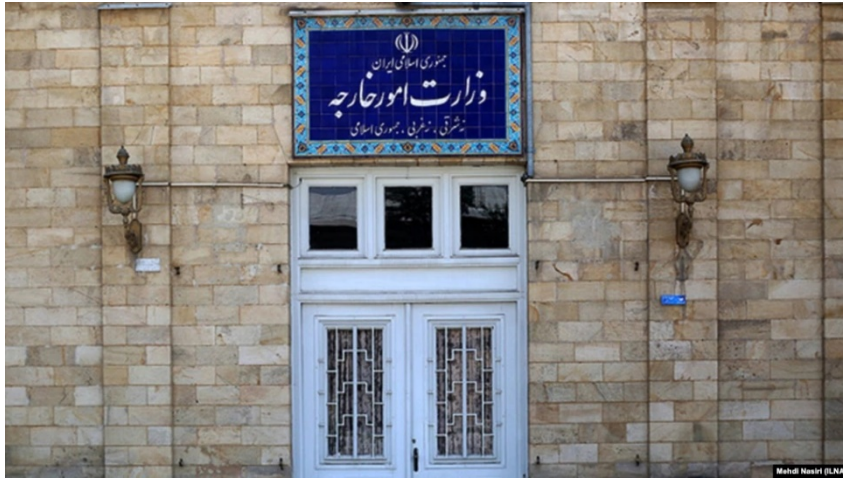
Şekil 1: İİC Dışişleri Bakanlığı'nın giriş kapısı (üzerindeki ana tabelada “Ne Doğu, ne Batı, Sadece İslam Cumhuriyeti” sloganı kazanmıştır)
