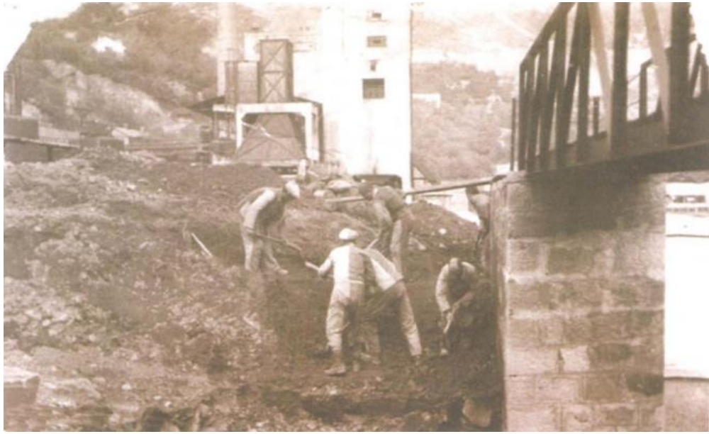
Şekil 3.52. Zonguldak'ta madenin yanında inşaat işi yapan mahkumlar (Sipahi, 2006).
