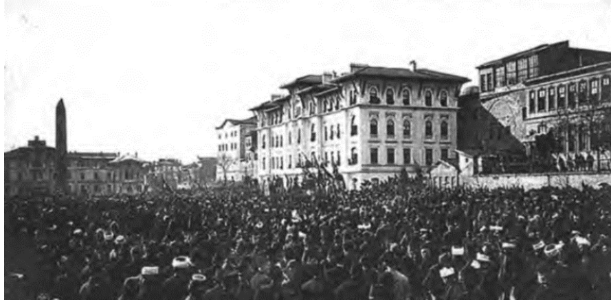
Şekil 3.46. II. Meşrutiyet döneminde Sultanahmed Meydanı ve fotoğrafın en sağ kısmındaki üç katlı Hapishane-i Umumî (Yıldız, 2012).
