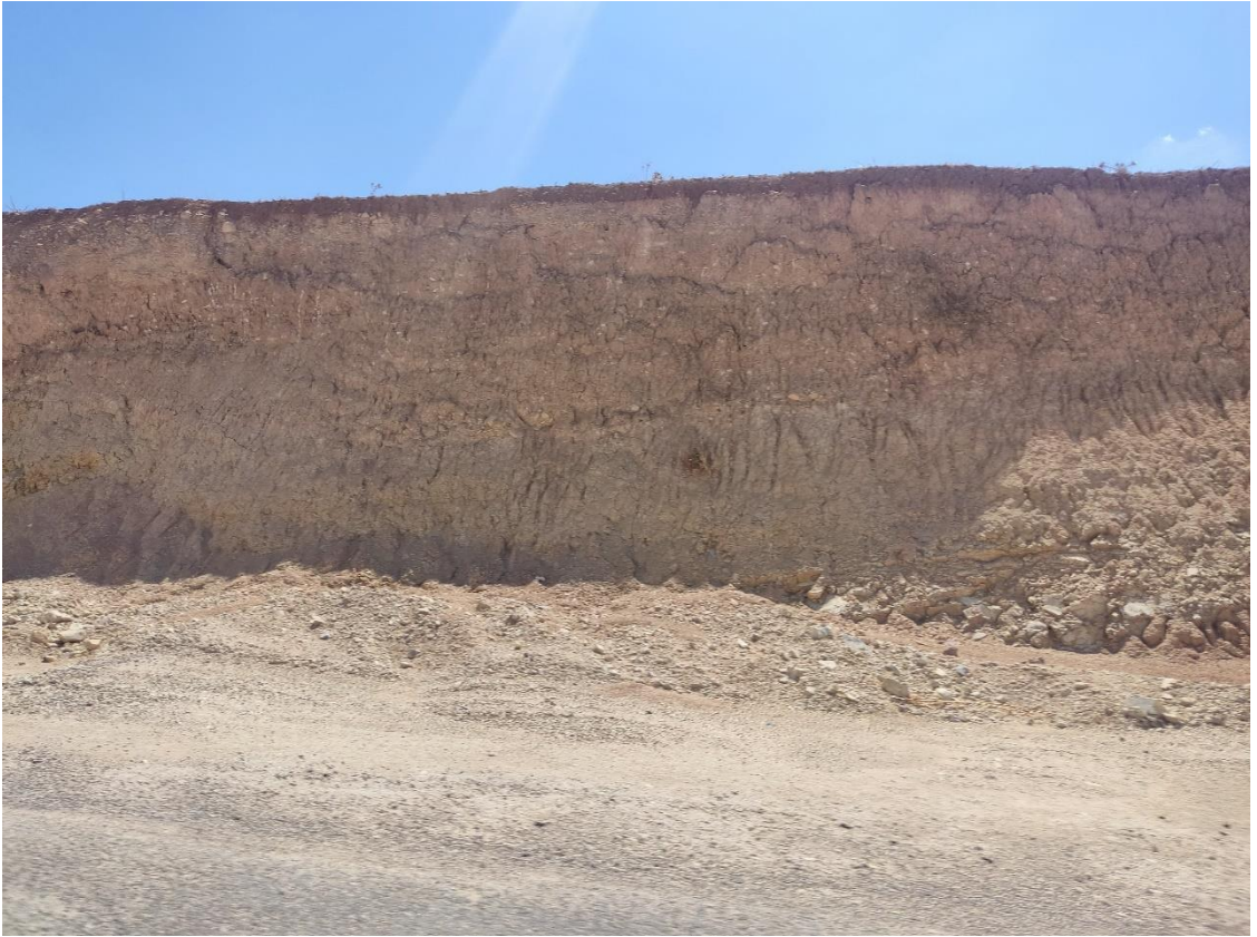
Fotoğraf 14: Kilis-İslâhiye Yolu Musabeyli yol ayrımında dike yakın eğime sahip Kırmızımsı kahverengi toprak kesiti üzerinde meydana gelen parmak erozyonu
