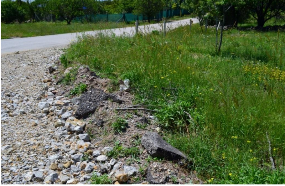
Fotoğraf 75: Yol kenarına atılan asfalt parçalarının üzerinde yetişen otlar uzun zamandan beri asfaltın o bölgede bulunduğunu göstermektedir. (Kaynak: Rümeyşa Kumral, 2023)
