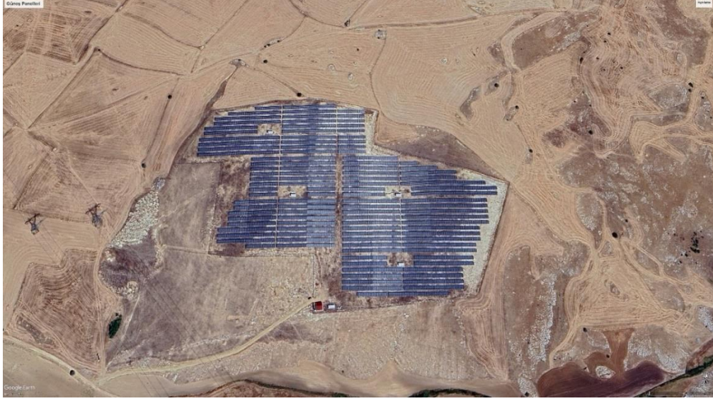
Fotoğraf 62: Subaşı Mahallesi kuzeyindeki, çevreden tortul taşınmasını ve damla erozyonunu engelleyen GES (Kaynak: Google Earth Pro)
