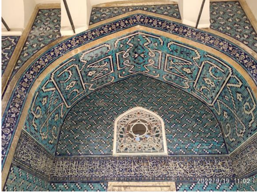
Fotoğraf 4: Çinili Köşk (1472), İstanbul: Türkiye Giriş Eyvanında Sırlı tuğlaların alternatif dizilimi ile çini mozaik tekniği kuşaklar 19.09.2022
